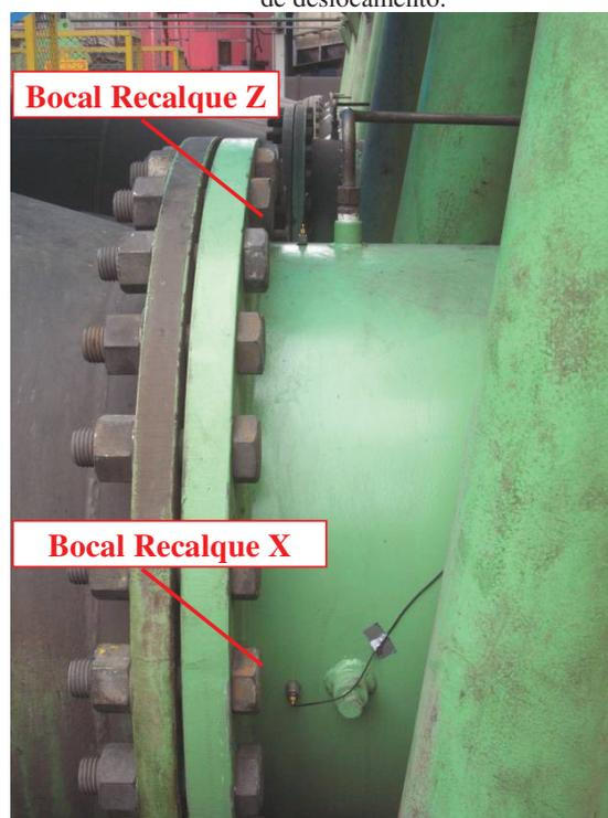
Figura 4.5: - Acelerômetros instalado no bocal de recalque da bomba.
