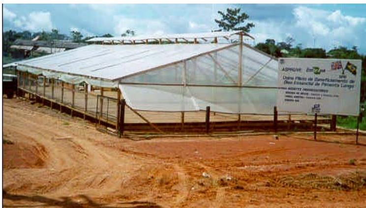
**Figura 2.9 - Foto do secador solar de biomassa de pimenta longa EMBRAPA, (2000).**
