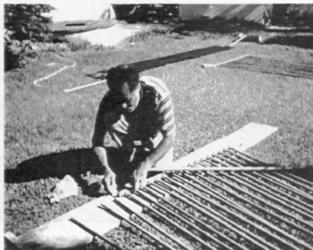
Figura 7.20 MÓDULO DA REDE SENDO COLOCADO NA COBERTURA DA VARANDA DA MORADIA
