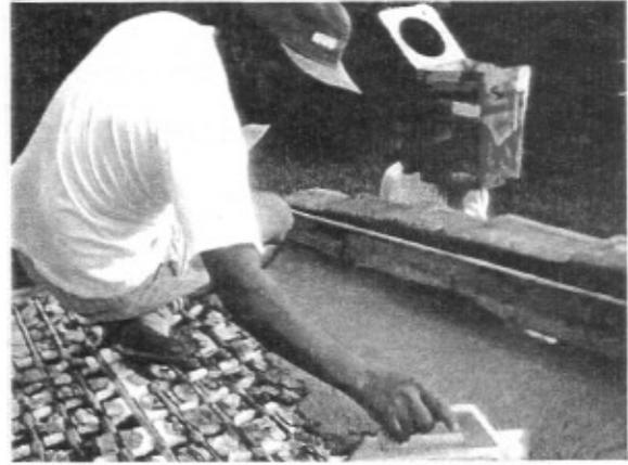
Após a cura do concreto (processo de secagem e endurecimento do concreto), a laje foi pintada, com uma demão de emulsão asfáltica (comercialmente conhecido como *Neutrol*). Posteriormente foi colocada a cobertura transparente feita de garrafas PET.
