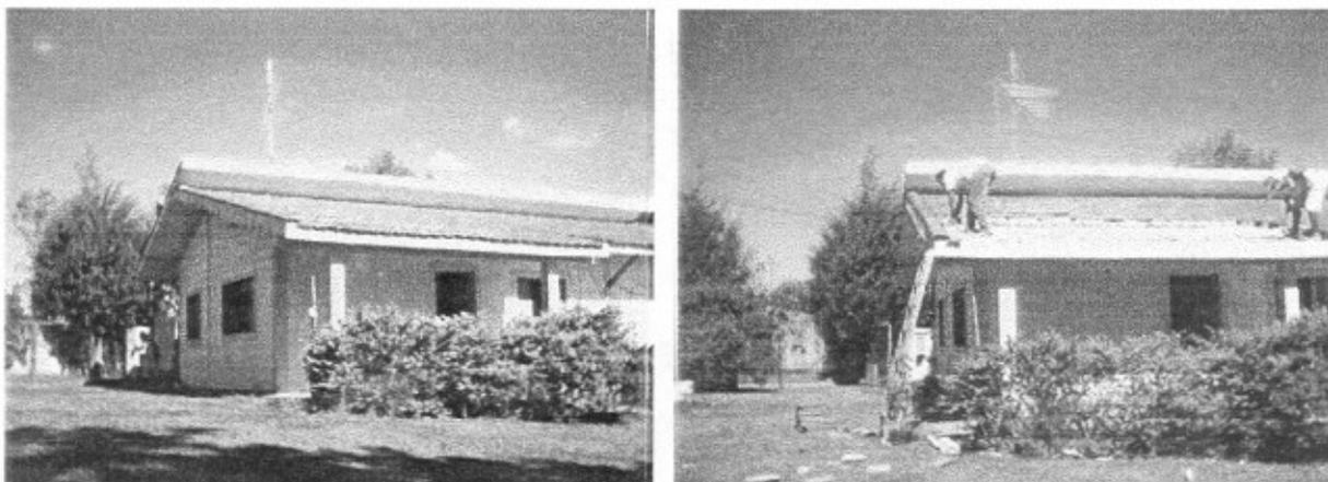
O módulo adotado possuiu 20 tubos de PVC - no total 4 módulos. A malha inteira ficou com 80 tubos de 1/2", colados a 160 Te de 3/4", com espaçamento útil de 4cm (6,50cm no eixo do Te). Entre os tubos foram colocadas 1280 placas de isopor, de 4cm x10cm x 2cm, e 1280 aletas de alumínio de embalagens de refrigerantes e cerveja.
