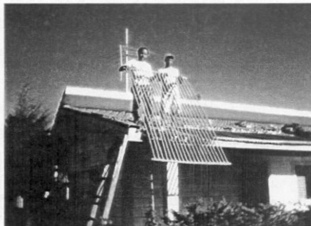
Figura 7.21 A REDE DE TUBOS DE PVC SENDO INSTALADA NA COBERTURA
