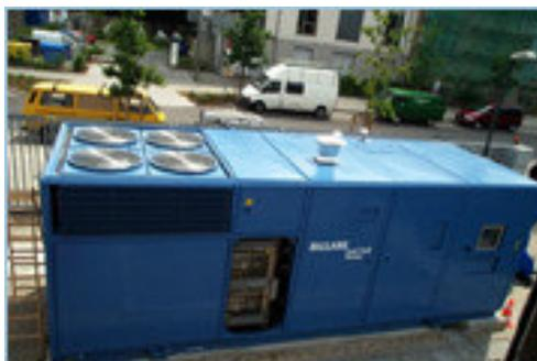
Figura 10 - Unidade PEMFC 250kW<sub>e</sub> da empresa canadense Ballard Power System
