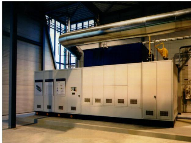
Figura 9 – Vista externa da unidade SOFC Siemens-Westinghouse 100 kW<sub>e</sub>
