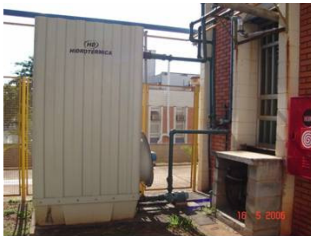
Figura 3-11 Vista dos trocadores de calor na linha de exaustão e da torre de resfriamento.
