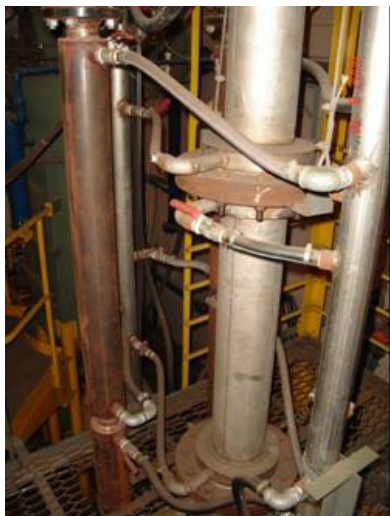
Figura 3-11 Vista dos trocadores de calor na linha de exaustão e da torre de resfriamento.
