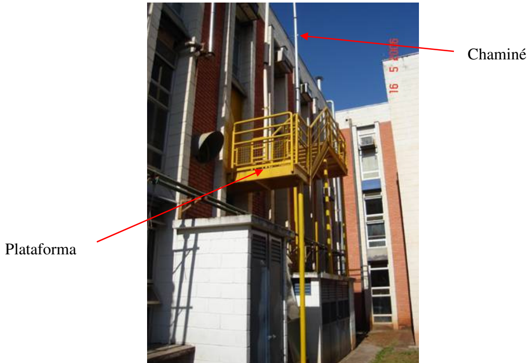
Figura 3-19 Vista da plataforma construída para a medição de mercúrio na chaminé.
