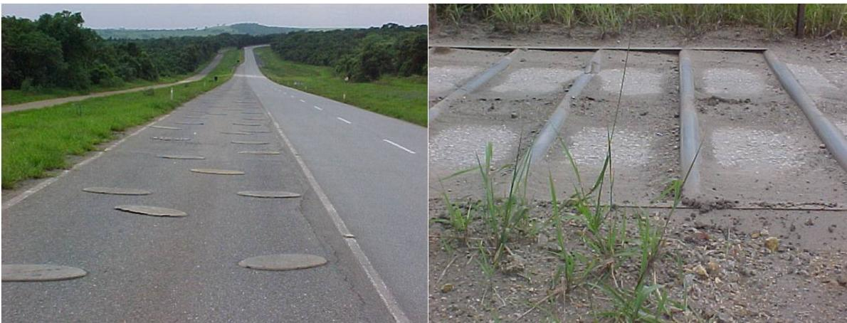
Figura 24 – Pista Bolachas de alta velocidade à esquerda e Mata-burro à direita
