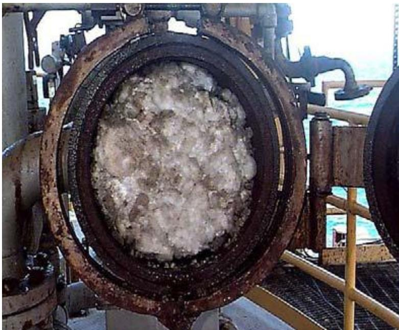
**Figura 2.12:** Hidratos no interior da linha.
