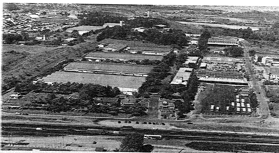
Figura 66 – Vista aérea da NEC DO BRASIL Fonte: NEC
