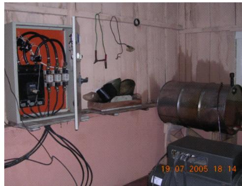
Foto 5.31: Quadro de proteção, seccionamento e controle de tensão, corrente e frequência.
