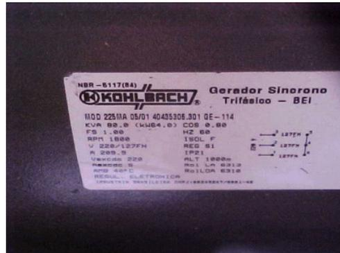
Foto 5.33: Detalhe da placa do gerador
