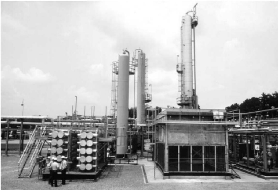
**Figura A.1: Comparação de tamanho: unidade de membranas versus unidade de amina. Fonte: Dortmundt e Doshi, 1999**
