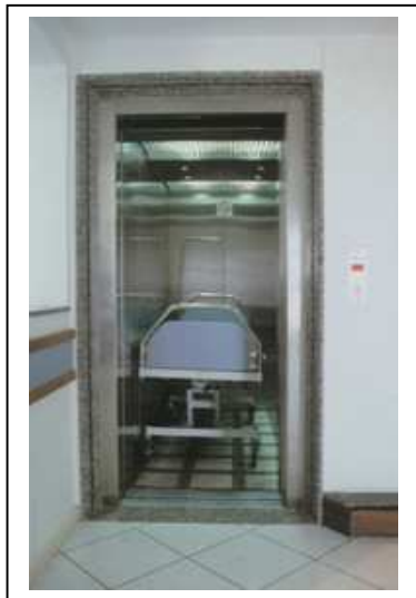
Fig. 4.6 – Elevador Hidráulico para Macas.
