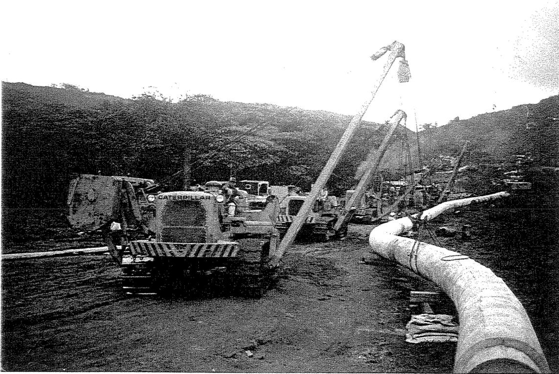
FIGURA 53: LANÇAMENTO DA COLUNA
