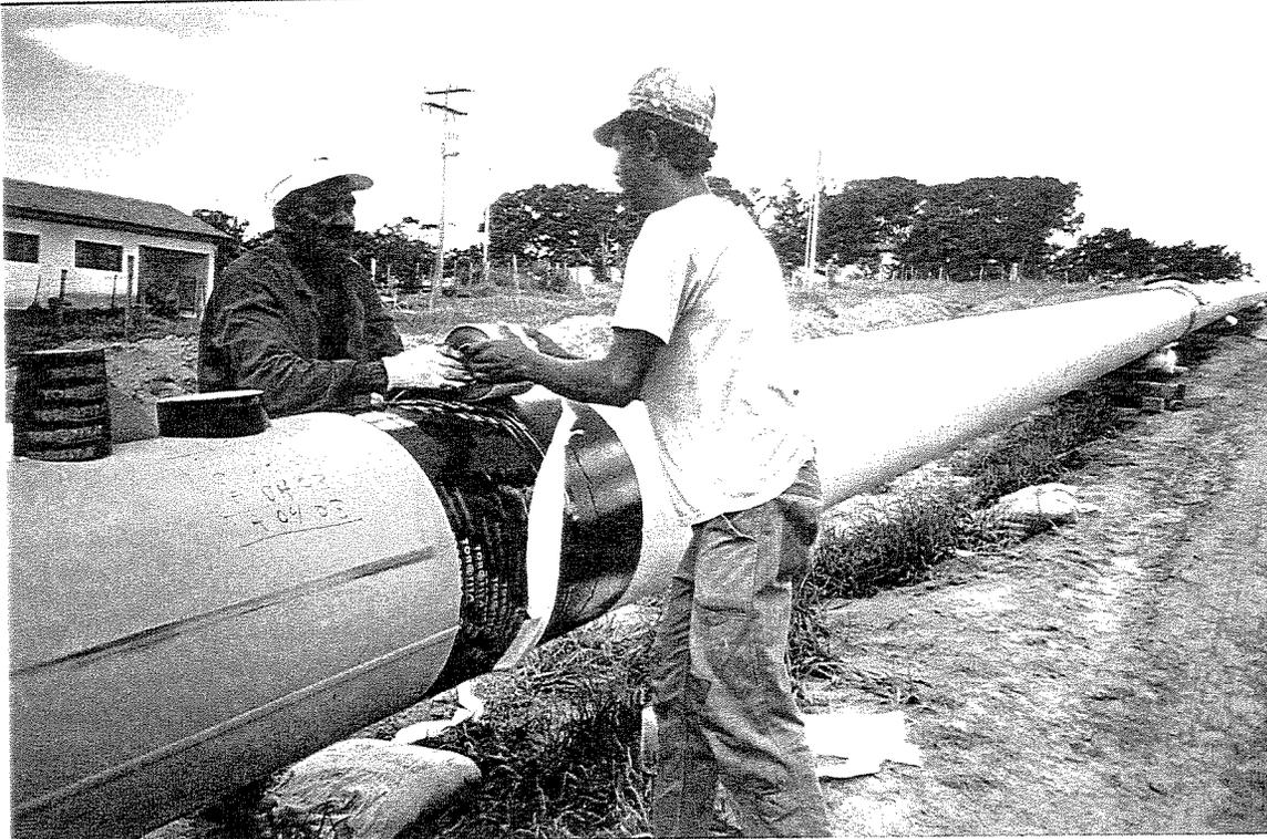
FIGURA 48: REVESTIMENTO DE JUNTAS
