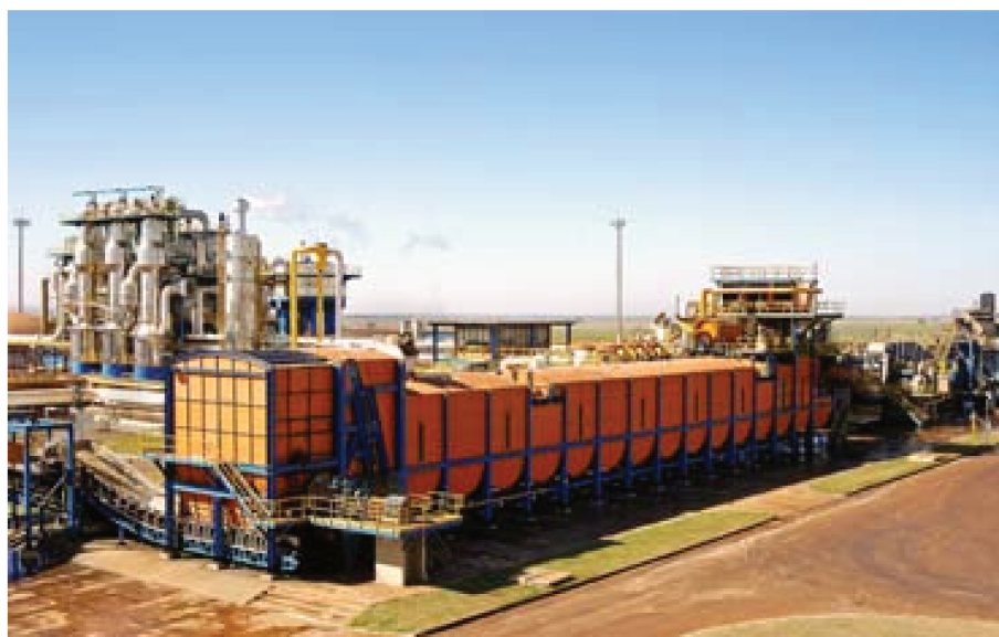
Figura 9. Foto de um difusor de percolação de colchão horizontal (imagem cedida por Uni-systems).
