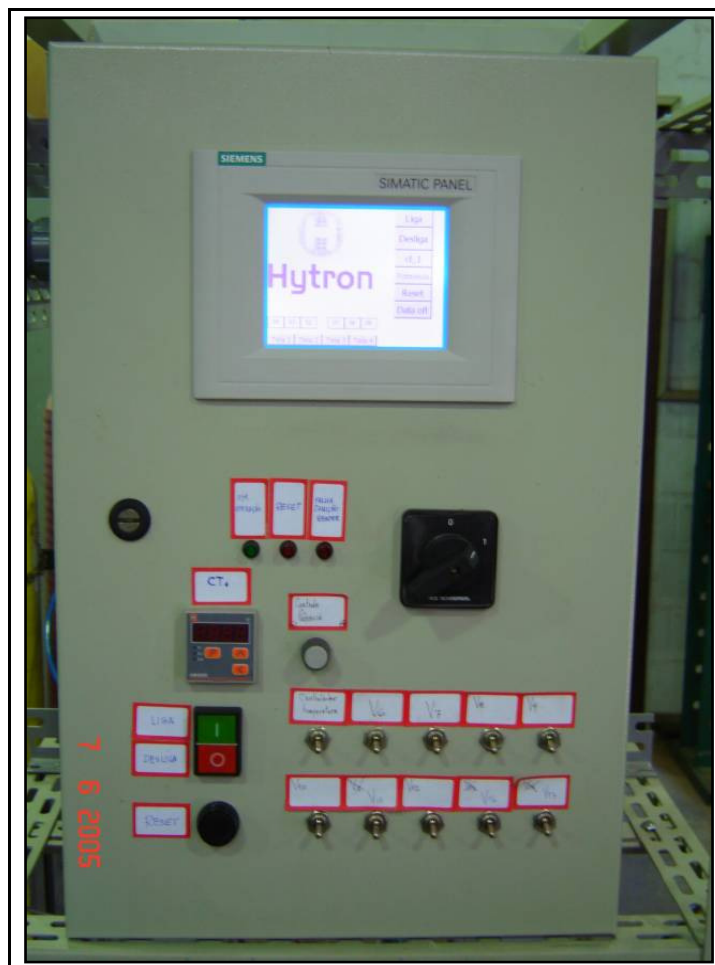
Figura 3.22 – Painel de controle atuação e coleta de dados. Fonte: Elaboração Própria.
