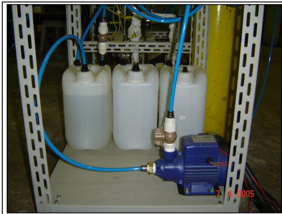
Figura 3.21 – Sistema de refrigeração. Fonte: Elaboração Própria.
