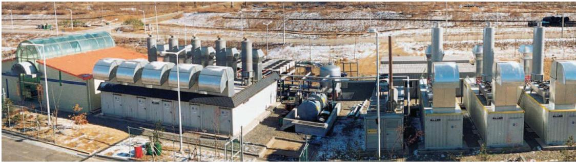
Figura 2.4 - Usina de cogeração Sudokwon alimentada com gás de aterro.
