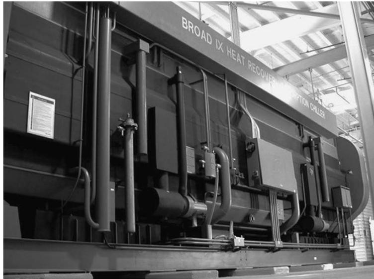
Figura 2.19 - Resfriador de líquido por absorção de duplo estagio Broad Co.
