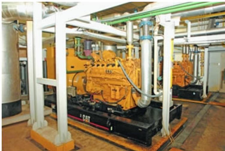
Figura 2.5 - Grupos geradores a gás G3412C suprem 790 kW e mais a energia térmica para climatização do aeroporto Zumbi dos Palmares.
