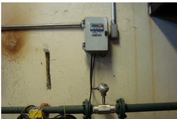
(a) Hidrômetro para o fluxo de água quente.
