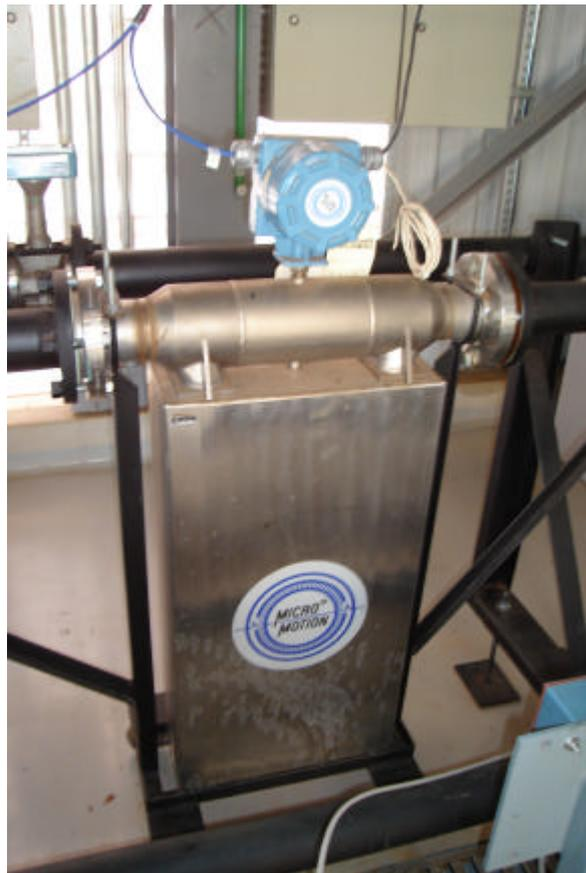
Figura V.9 - Medidor de vazão mássico (Coriollis).
