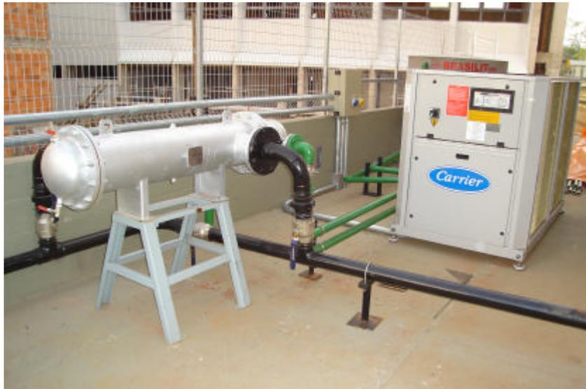
Figura V.14 – Trocador de calor e bomba de calor do sistema.
