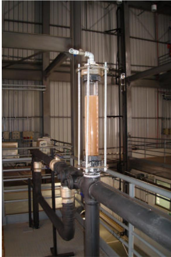
Figura V.12 - Separador gravitacional, transparente, para purgar ar do sistema.
