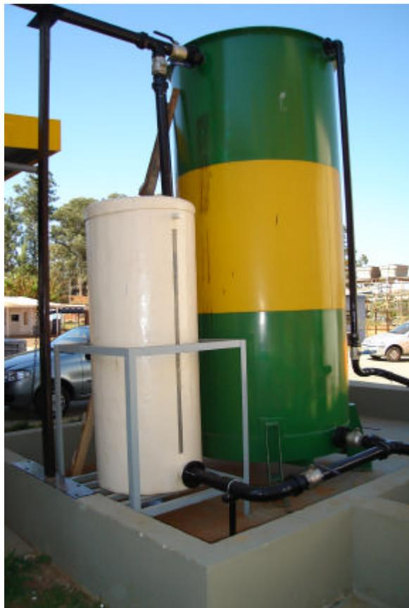
Figura V.15 – Tanques de armazenamento do fluido de trabalho.
