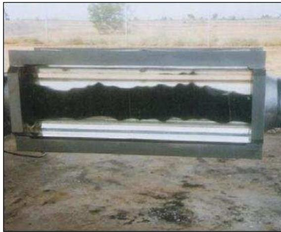
Figura 2.4: Aplicação comercial do core flow na linha instalada em San Tomé, Venezuela.
