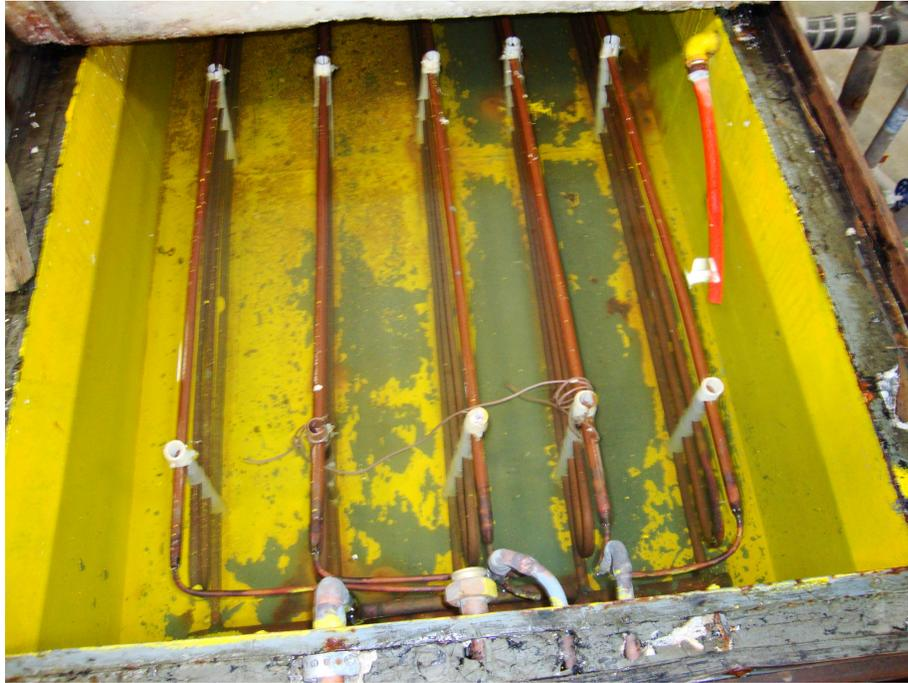
Figura 3. 5 – Fotografia do reservatório de água gelada e gelo.
