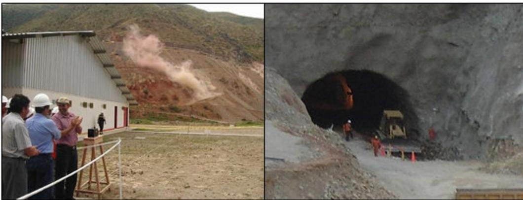
Figura 1.6 – Presa Limón – Peru. Início da abertura do túnel de desvio com a utilização de explosivos, limpeza e conformação da seção do túnel.
