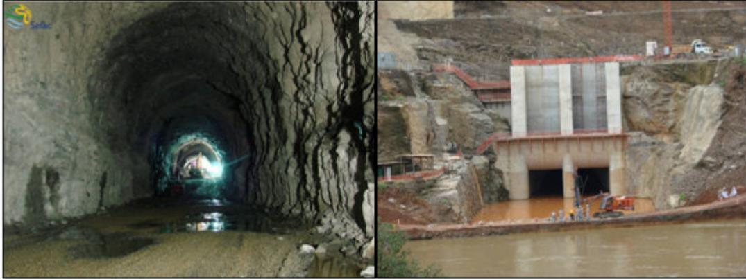
Figura 1.7 – AHE Serra do Facão – GO. Vista interna do túnel de desvio, e vista do emboque do túnel (montante para jusante).
