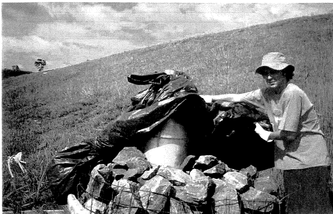
Figura 4.2. Encaixe da peça cônica e montagem da lona plástica no dreno nº 94
