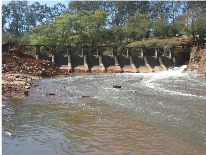
**Figura 2.3 - Barragem com vertedouros da PCH Corumbataí, em Rio Claro-SP.
