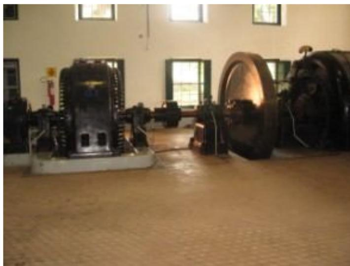
**Figura 2.5 - Conjunto turbina-gerador da PCH Corumbataí, em Rio Claro-SP.
