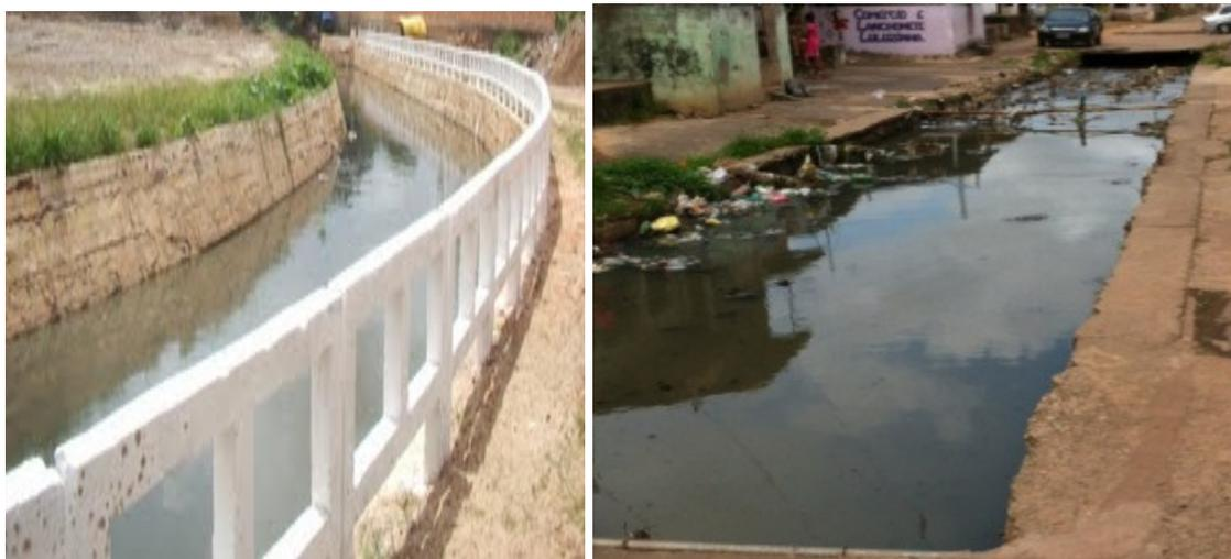
Figuras 3.6a e b Escoamento de esgoto em canal e vala.
