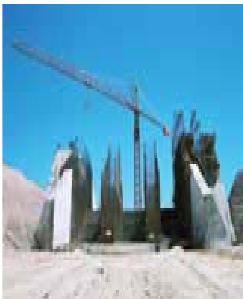
(46) Foto do canteiro de obra, construção das comportas da barragem de Corumbá IV, março de 2003. Fonte: Ministério Público de Goiás.
