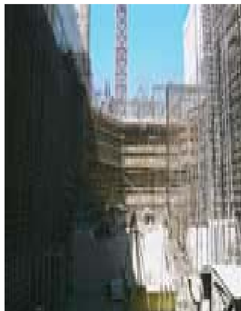
(47) Foto do canteiro de obra, construção do paredão da barragem de Corumbá IV, em março de 2003. Fonte: Ministério Público de Goiás.
