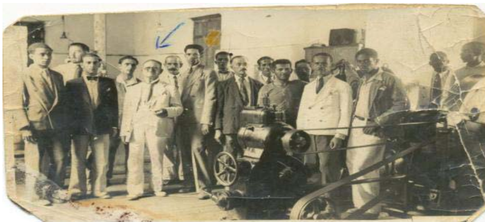
(09a) Foto de Joaquim Guedes de Amorim e funcionários em 19/04/1920, no dia da inauguração da usina termelétrica a vapor queimando carvão vegetal, com 25 HP de potência instalada. Fonte: acervo fotográfico da CELG. Visita técnica em novembro de 2004.
