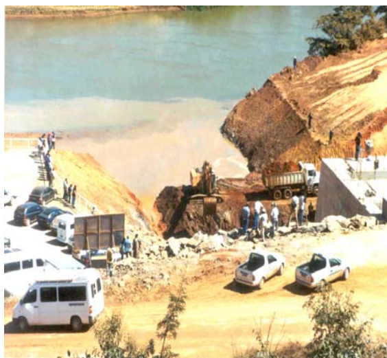
(53) Foto de homens trabalhando na construção da barragem de Corumbá IV, ao mesmo tempo em que visitantes especulam a compra de lotes. Fonte: pesquisa de campo, em fevereiro de 2005.
