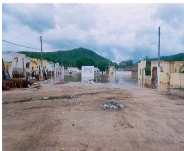
(59) Foto do referido bairro alagado em função do enchimento do reservatório da usina Cana Brava em novembro de 2001. Fonte: secretaria do MAB em Goiás.
