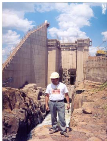
(34) Foto do autor visitando o canteiro de obra da barragem da usina Espora no rio Corrente entre os municípios de Aporé e Serranópolis/GO. Fonte: pesquisa de campo realizada em março de 2005.
