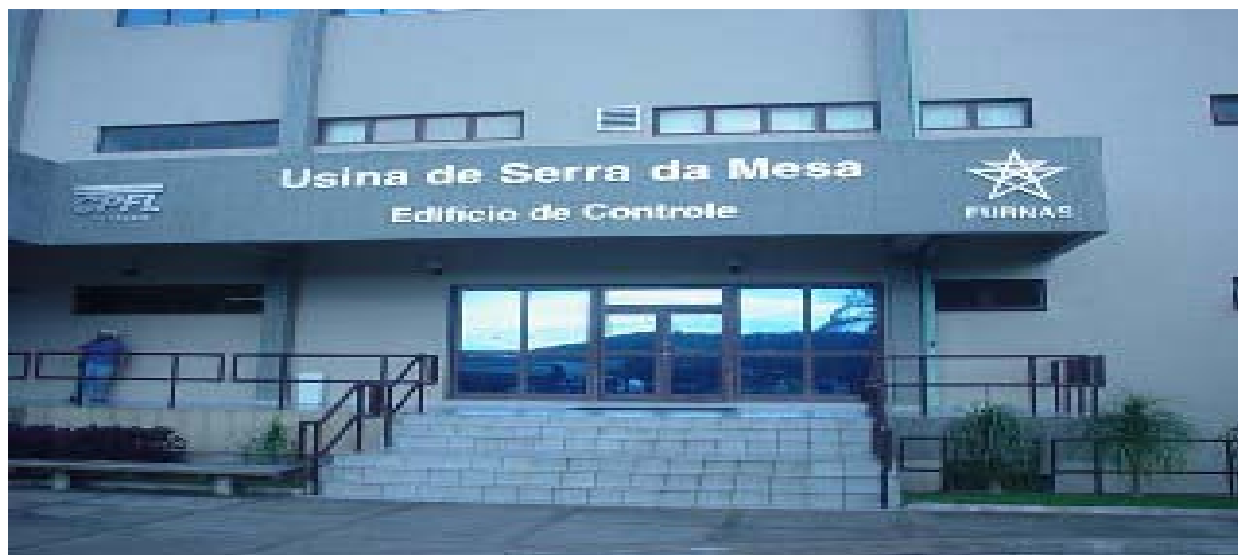
(55) Foto da fachada do prédio de controle e operação da usina de Serra da Mesa. Fonte: pesquisa de campo em abril de 2005.
