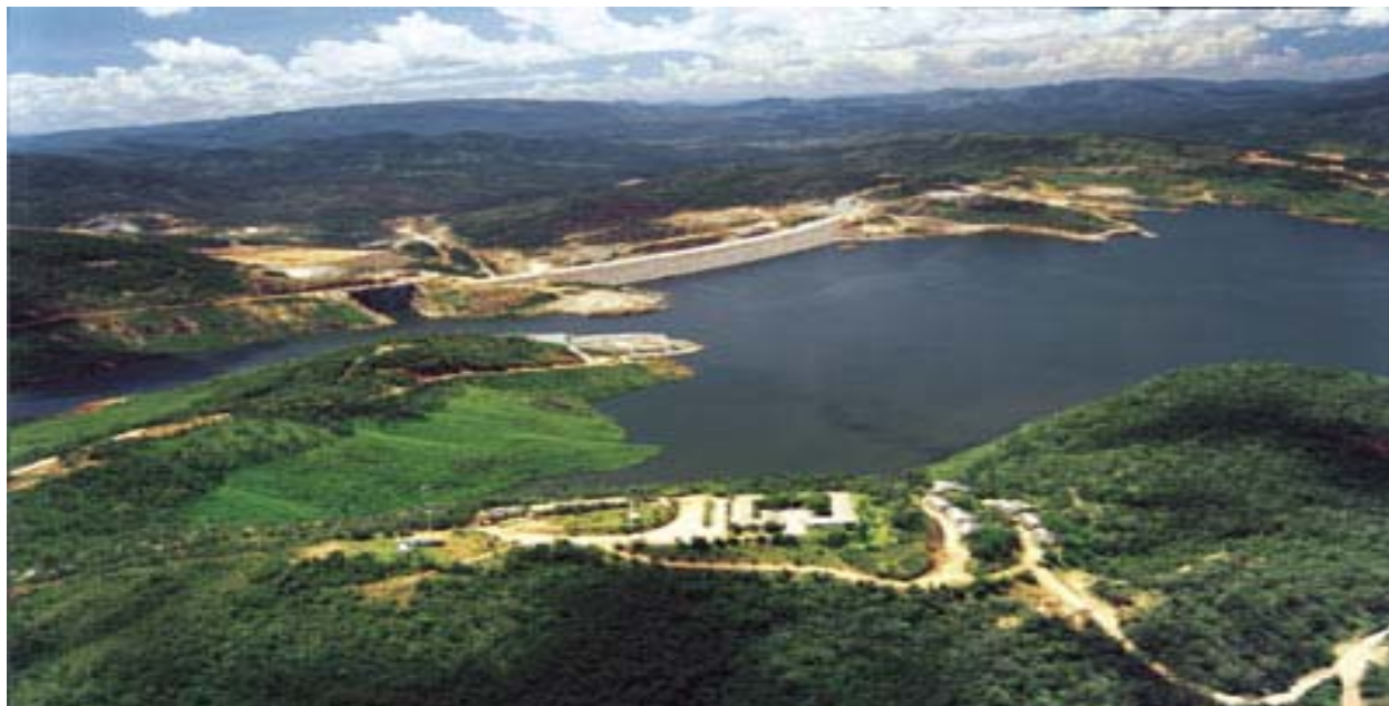
(16) Foto da usina hidrelétrica de Serra da Mesa inaugurada 1998. Fonte: acervo fotográfico de FURNAS. Foto doada pelo engenheiro operador da referida usina Marcos Castanheira em 18 de março 2005, em visita técnica.
