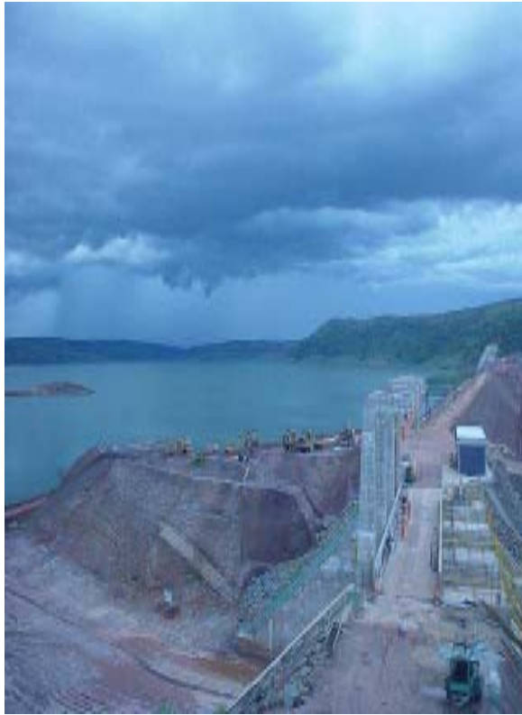
(48) Foto do canteiro de obra da usina hidrelétrica Corumbá IV (vertedor de cheias). Fonte: pesquisa de campo em fevereiro de 2005.
