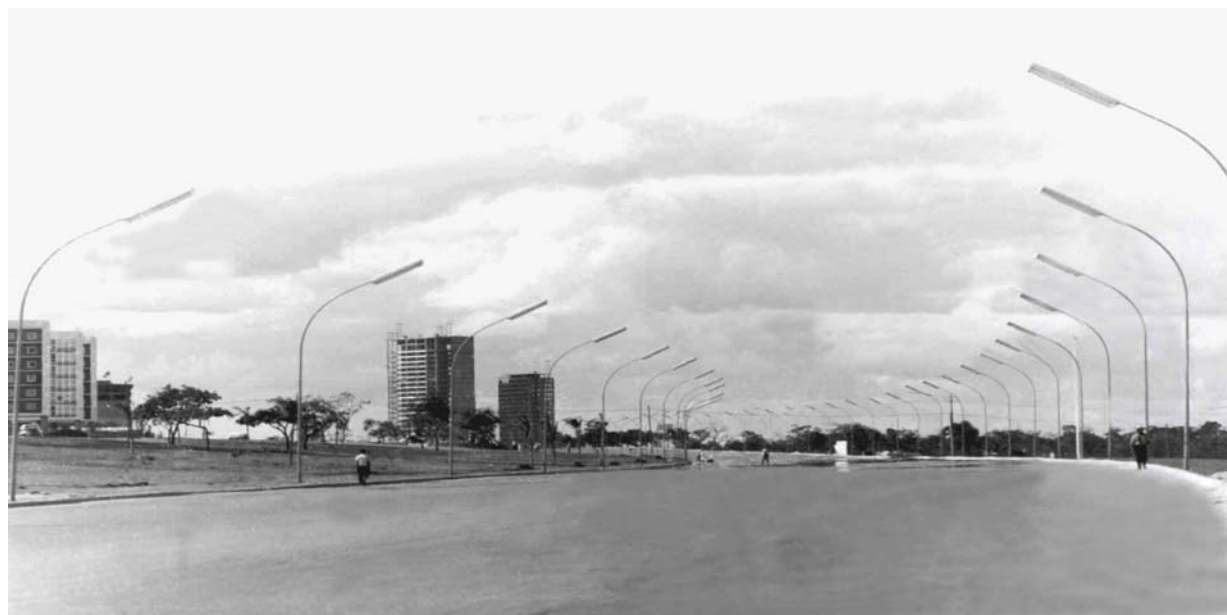
(13) Foto de Luminária Power Groove eixo Rodoviário Sul de Brasília, em 1974. fonte: acervo fotográfico da CEB. Visita técnica no Centro de Memória da Companhia Energética de Brasília em abril de 2005.
