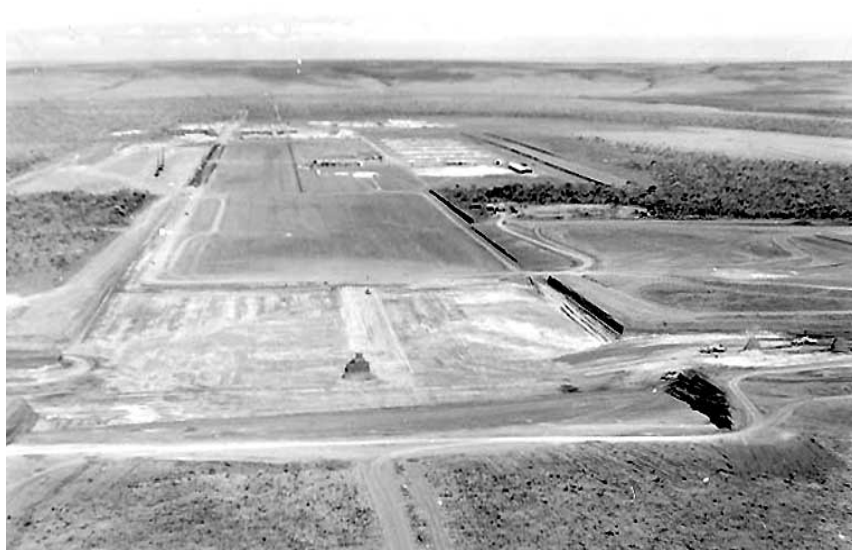
(07) Foto do marco inicial da construção da nova Capital da República, em 1957. Em primeiro plano, o local da plataforma rodoviária. Em segundo plano, o local onde surgirão os Ministérios e o Congresso Nacional. Movimentação de terra para aplinar o retângulo da Rodoviária (encaixada entre os taludes em primeiro plano) até o Congresso Nacional. O testemunho de terra marca o ponto zero — cruzamento dos eixos Monumental e Rodoviário — e indica o nível anterior do terreno. Foto: acervo da Fundação de Cultura do Distrito Federal.
