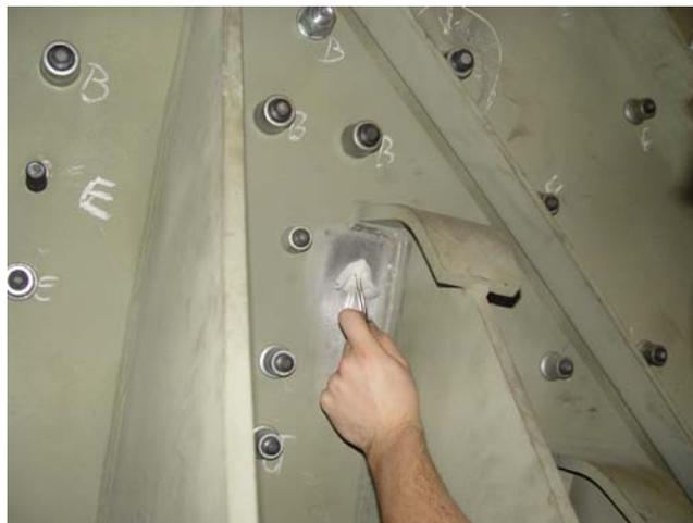
**Figura 5.22 – Processo de condicionamento da superfície**
