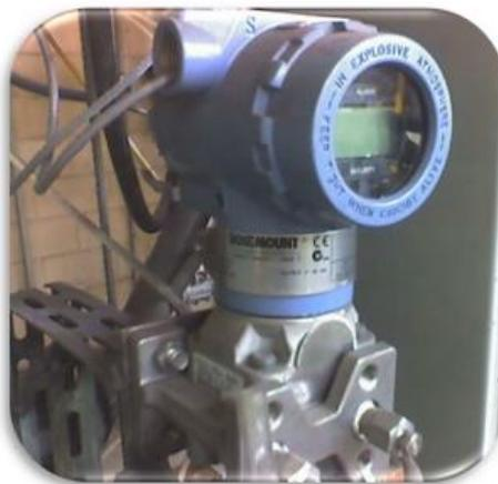
Figura 3.12 - Fotografia do transdutor de pressão Rosemount 3051.
