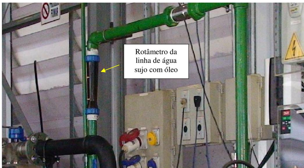
Figura 5.11. Rotâmetro da linha de água impregnado com óleo.
