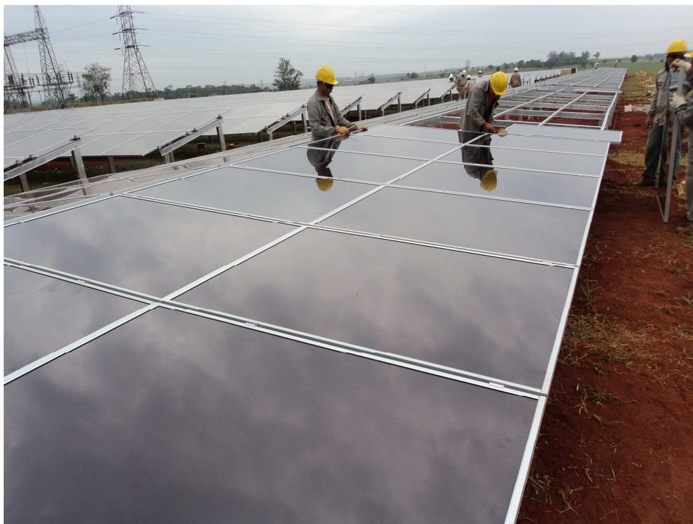
Figura 4.8 Instalação dos painéis da A2 próximo ao talude com inclinação de 6° e com “duas águas”.
