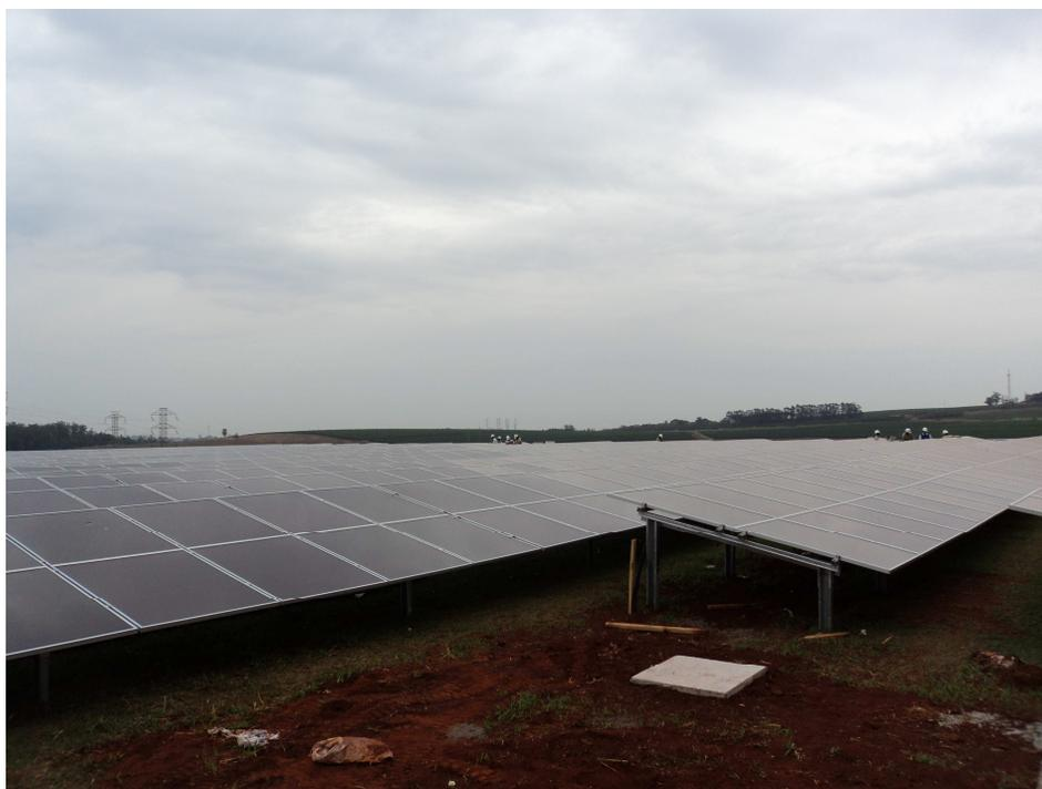
Figura 4.9 Painéis da A2 na parte central: meia água com inclinação de 12°.
