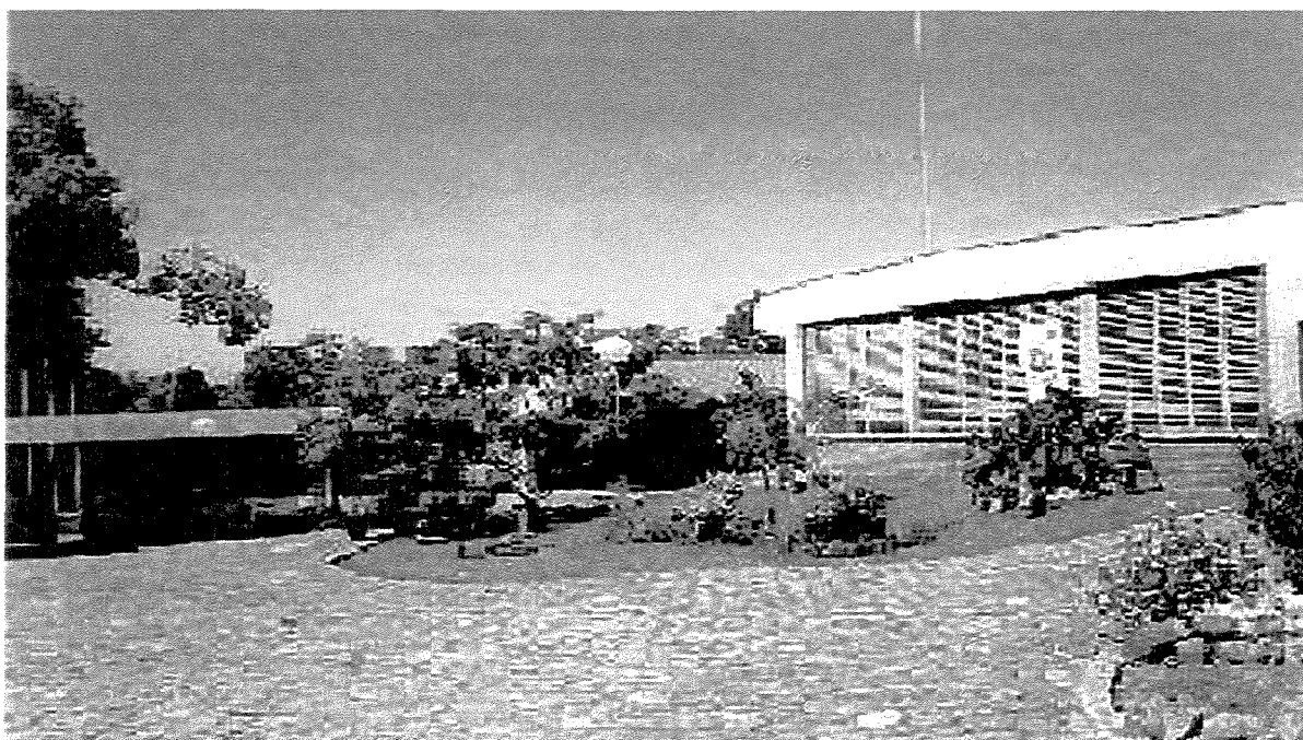
Figura 1: Colégio Técnico Industrial Prof. Isaac Portal Roldan
