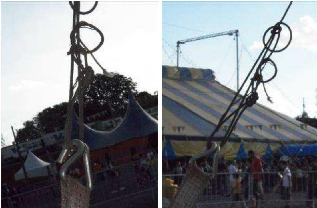
Na imagem acima, podemos notar que dois cabos se unem com a utilização de um nó, técnica inapropriada e de alto risco.
