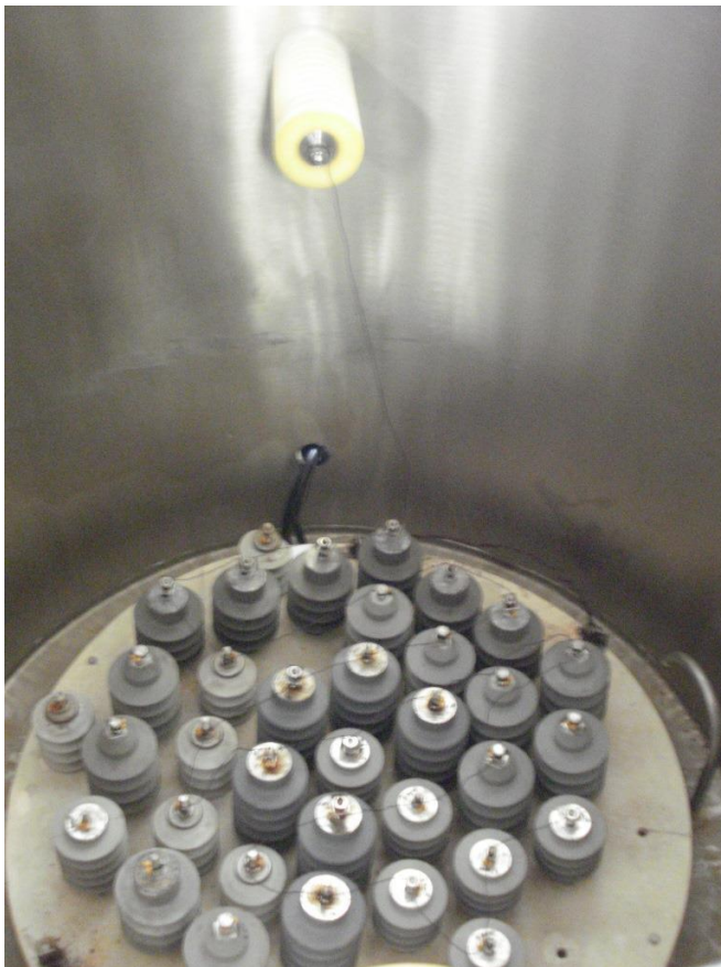
Figura 4.4 – Instalação dos para-raios nos tanques de ensaios energizados
