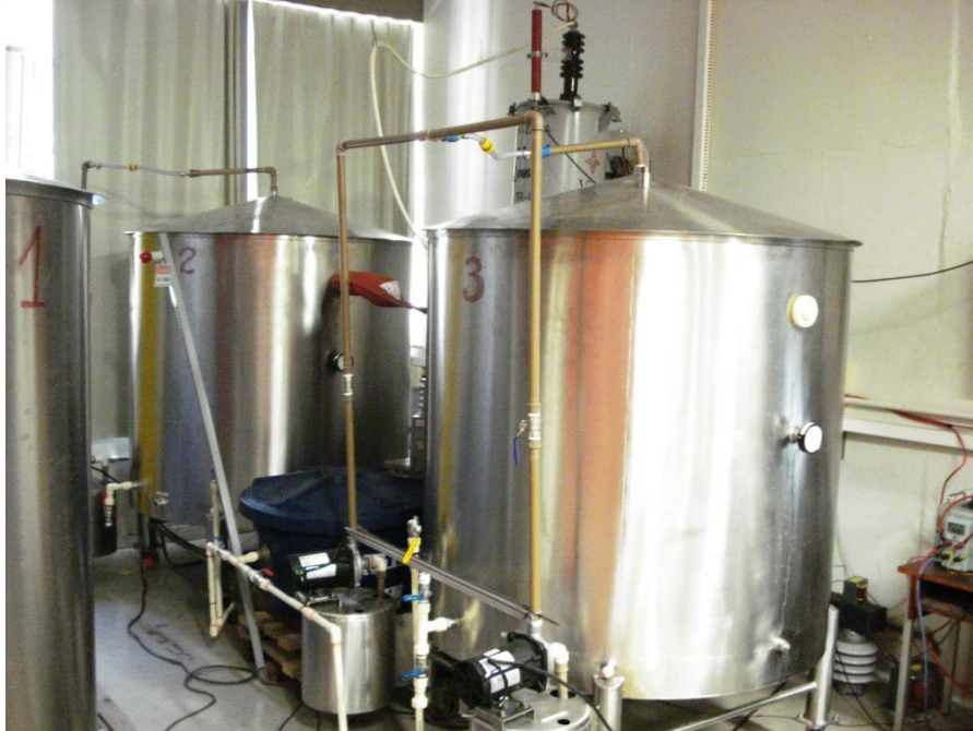
Figura 4.3 Tanques para ensaios energizados
