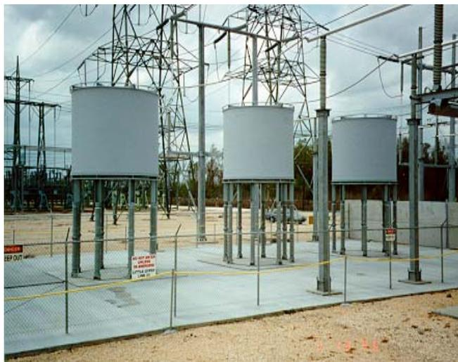
Fig. 3.2 – Reatores limitadores de corrente conectados a um sistema de energia elétrica [20].
