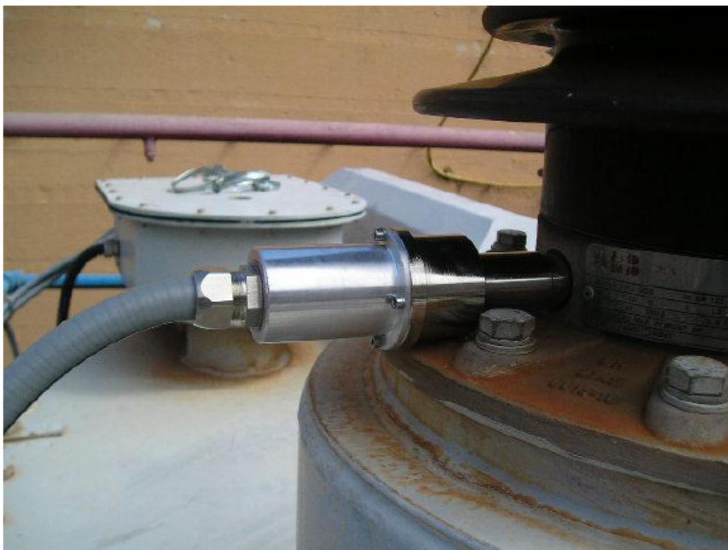
Figura 25 – Sensor de Descargas Parciais Instalado na Bucha de Alta Tensão
