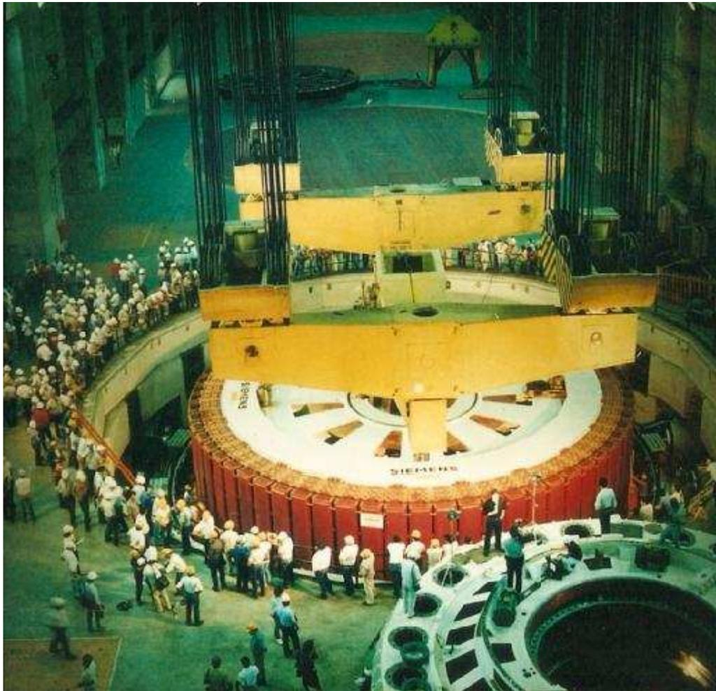
Figura 2.10 – Montagem de um dos geradores de Itaipu
