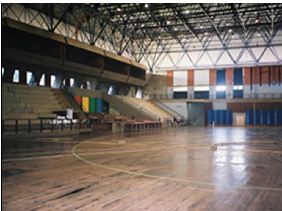
Figura 4.20 – Ginásio de esportes (vista interna).
