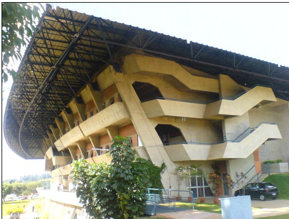
Figura 4.19 – Ginásio de esportes (vista externa).
