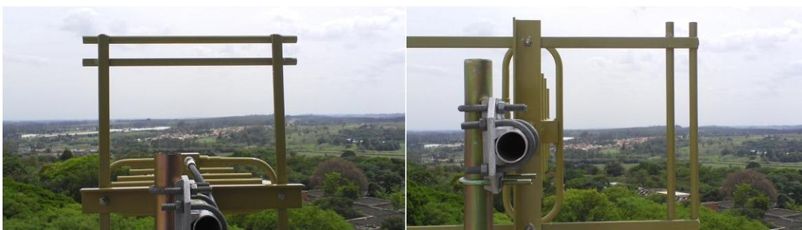
Figura 11 - Antenas Yagi H/V no Ponto de Transmissão.
