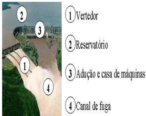
Figura 3.3: Elementos de uma usina hidrelétrica
