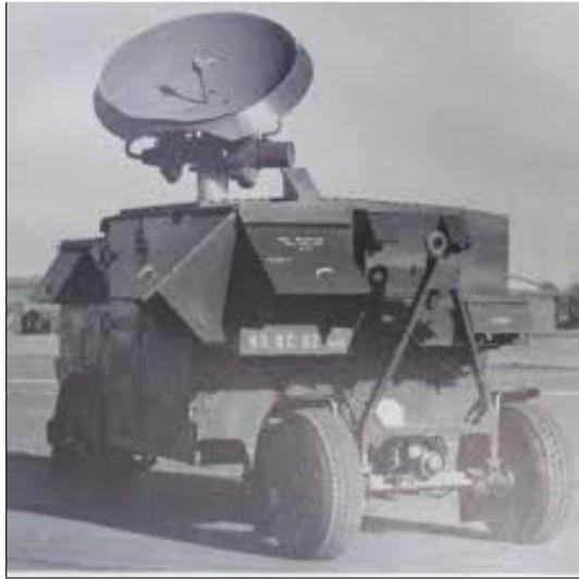
Figura 1.6: Primeiro radar monostático britânico
