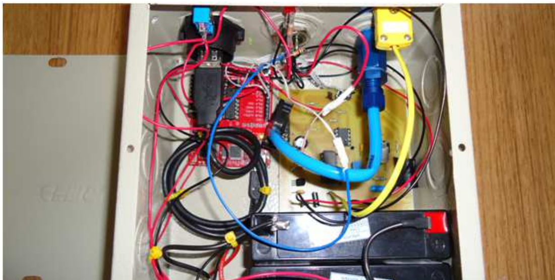
Figura 30: Montagem interna do sistema PADSi®.
