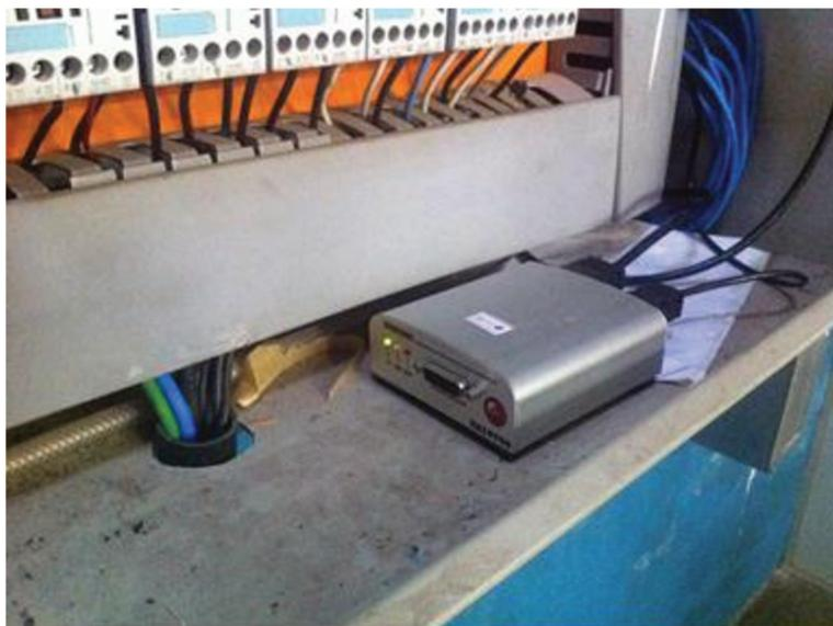
Figura 55 - Módulo de leitura de dados no painel da máquina.
