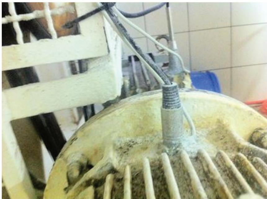
Figura 53 - Detalhe do sensor de vibração e temperatura instalados no motor da lavadeira 42.
