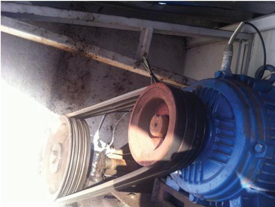
Figura 51 - Instalação do sensor de vibração no motor e mancal do ventilador.
