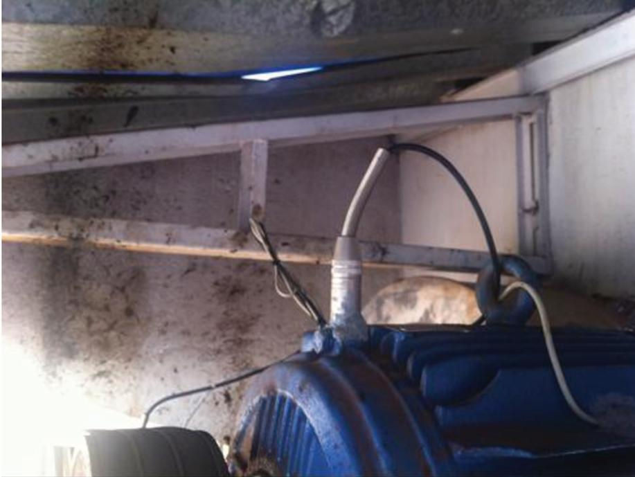
Figura 50 - Detalhe da instalação de sensor de vibração no motor do ventilador.
