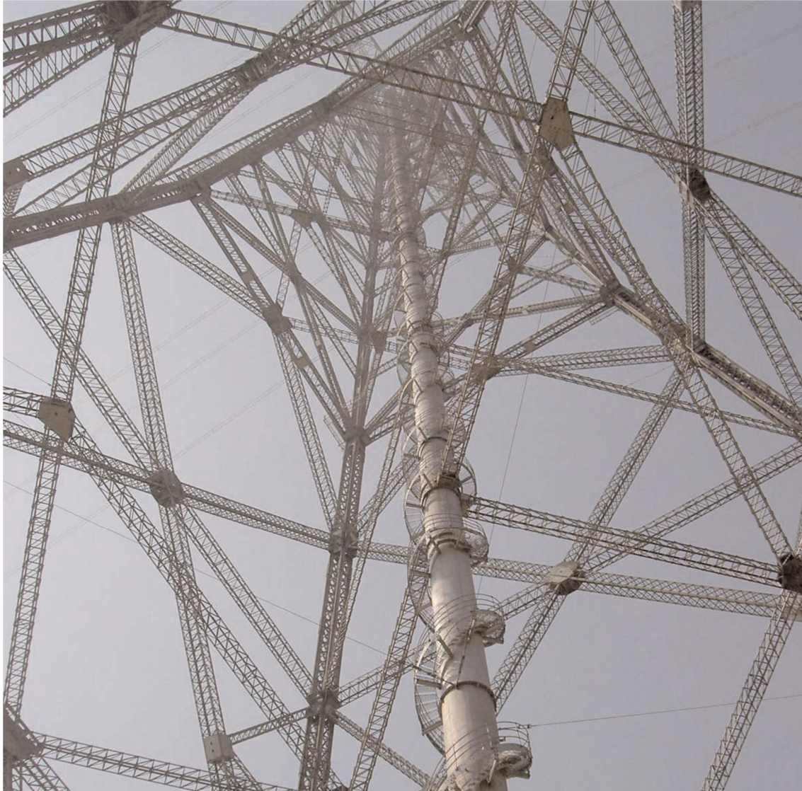
Figura 2.5. Visão interna da estrutura metálica da torre.
