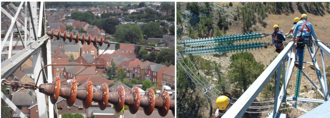
Figura 1.7. A esquerda tem-se uma cadeia de isoladores de porcelana e a direita isoladores de vidro.
