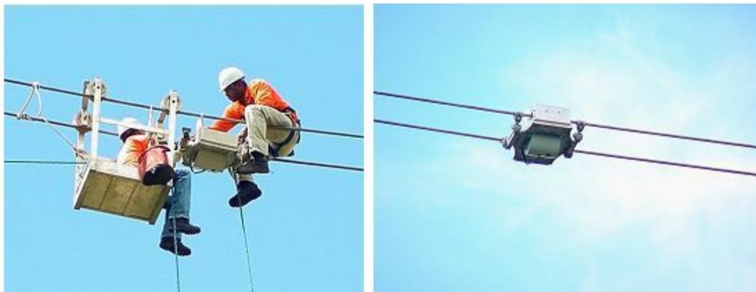
Figura 3.6: Instalação do elemento sensor na linha de transmissão.
