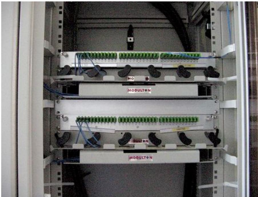
Figura 3.7: DG óptico do cabo OPGW na sala de telecomunicações.
