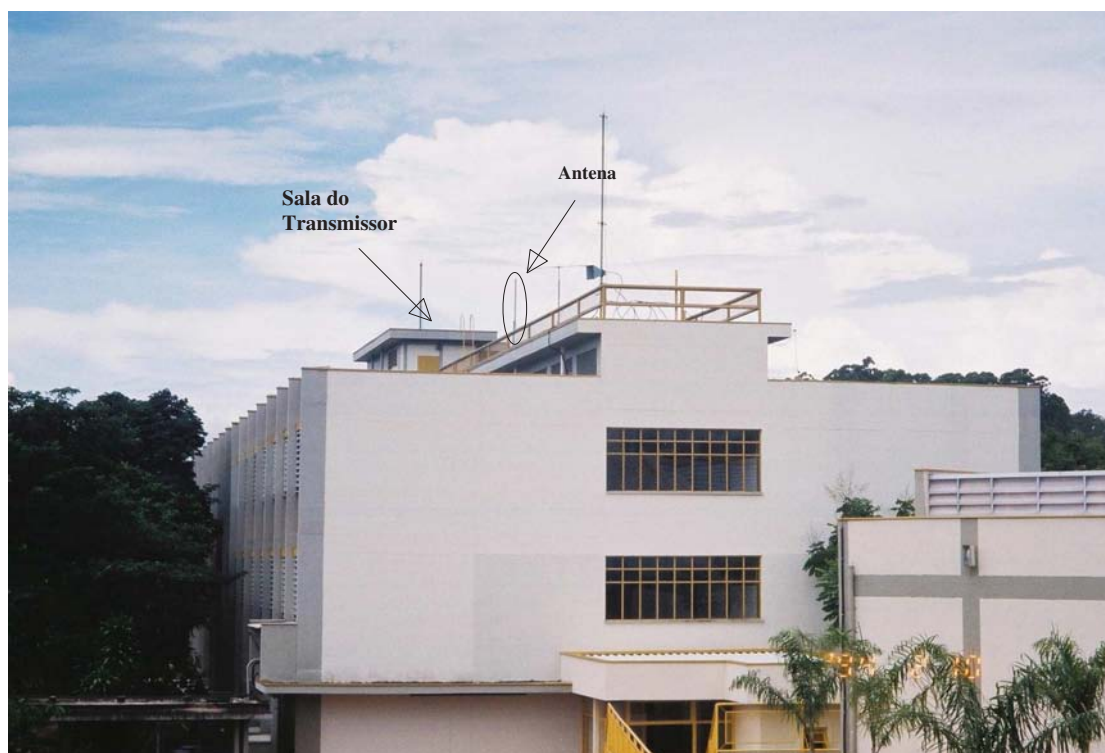
Fig. 4.2: Vista da cobertura do prédio E da FEEC.
