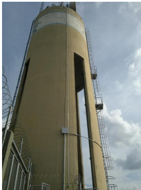
Figura 2.23 Estrutura de torre de caixa de água utilizada como barreira física
