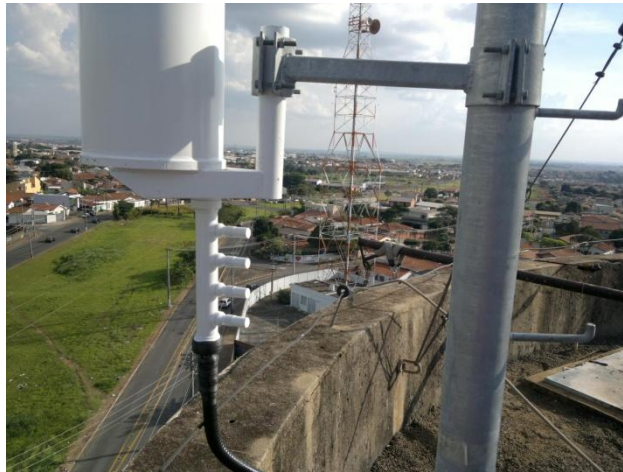
Figura 2.25 Antena de Transmissão utilizando barreira física
