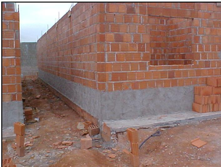
Figura 3.27 – Detalhe da argamassa de revestimento com adição de impermeabilizante aplicada na base das alvenarias.
