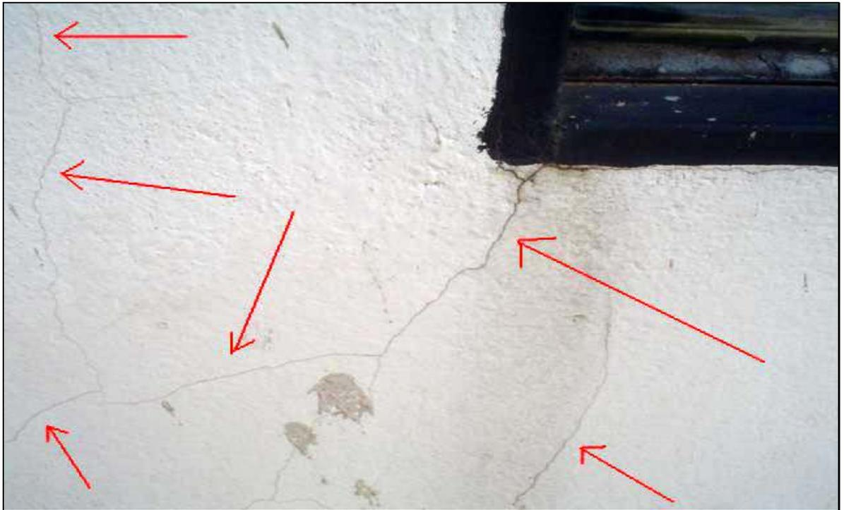
Figura 3.40 – Fissura por atuação excessiva de carga e fissuras por retração da argamassa do revestimento.
