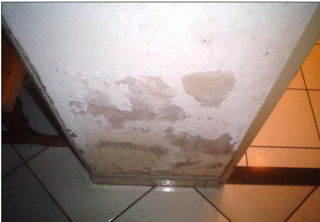
Figura 3.42 – Degradação da argamassa de revestimento por eflorescência (1).
