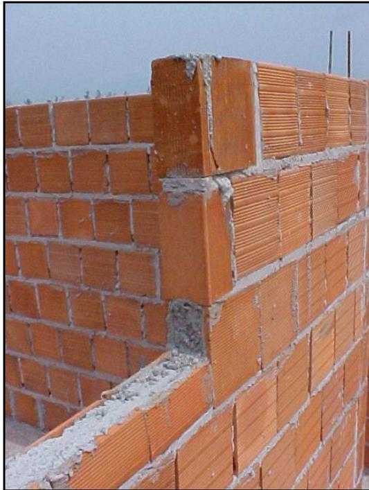
Figura 3.22 – Detalhe da contraverga executada em bloco canaleta.
