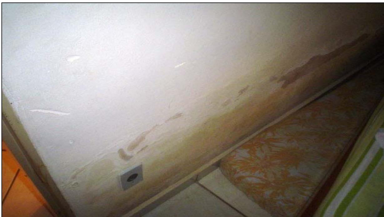
Figura 3.43 – Degradação da argamassa de revestimento por eflorescência (2).
