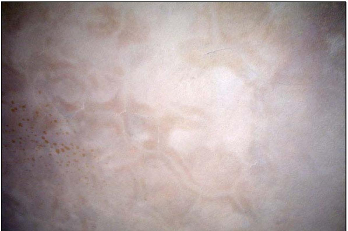
Figura 3.41 - Fissuras generalizadas por retração da argamassa de revestimento.
