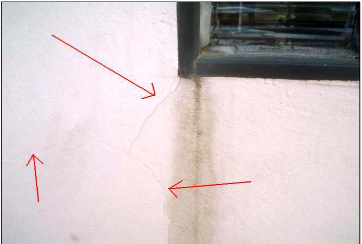
Figura 3.39 – Fissura por atuação excessiva de carga (3)
