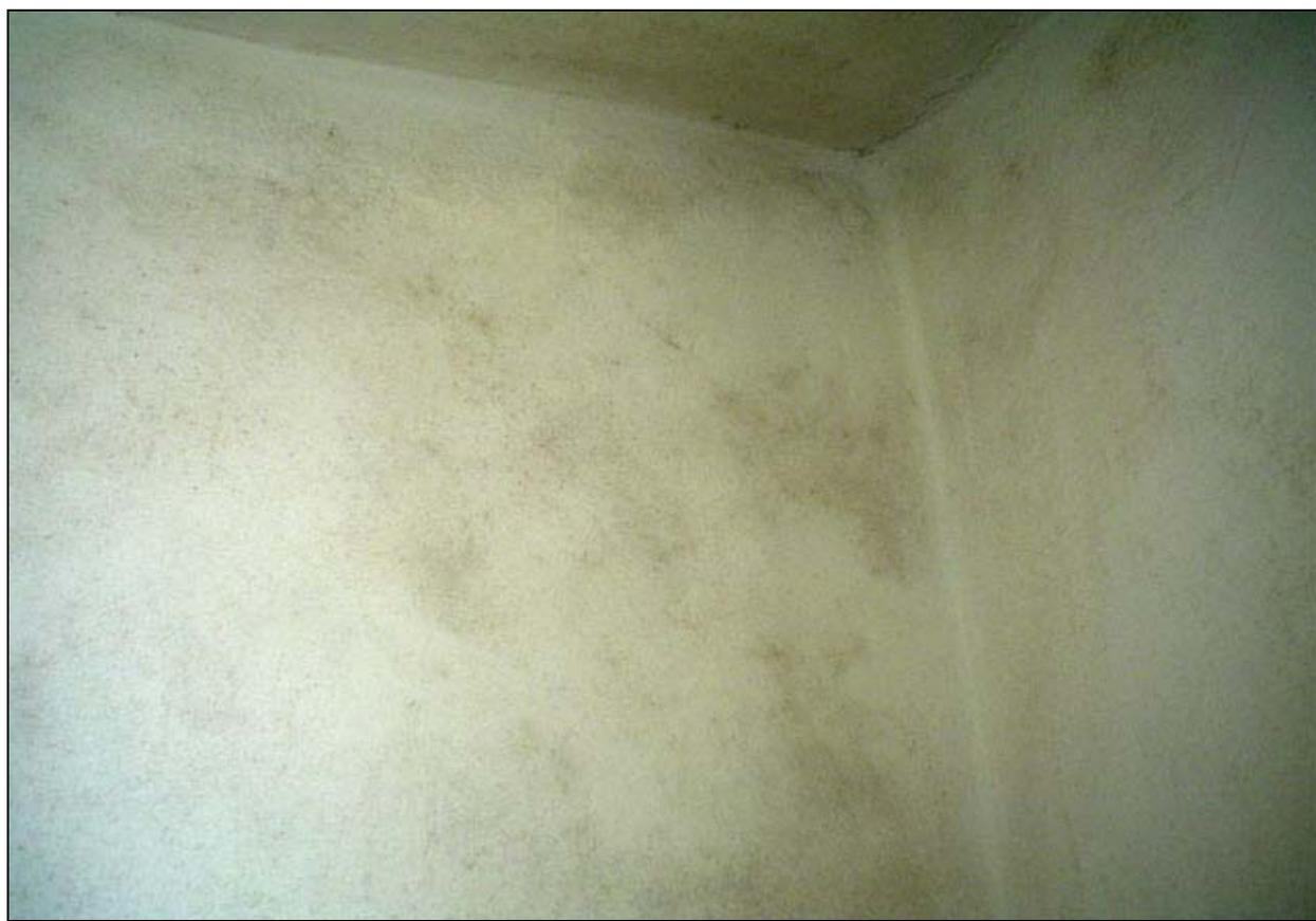
Figura 3.44 - Umidade na face interna da alvenaria decorrente de fissuramento da face externa da alvenaria.
