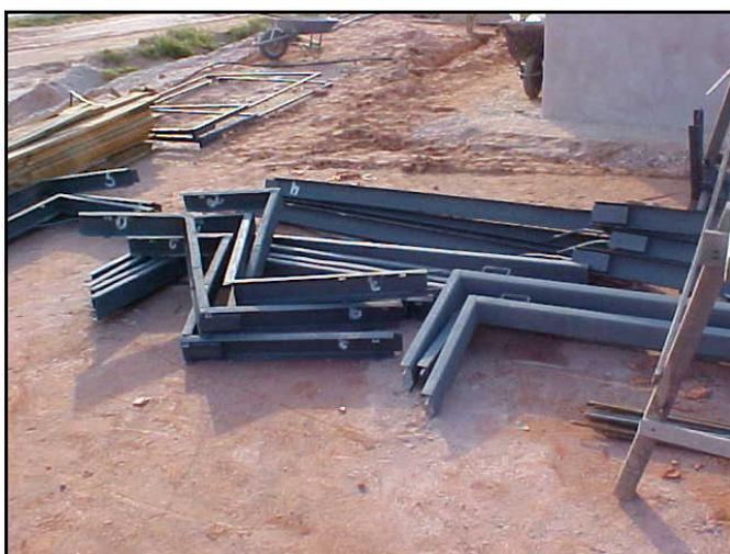
Figura 3.17 – Perfis metálicos para delimitação das bordas da laje do *radier* (gabaritos).
