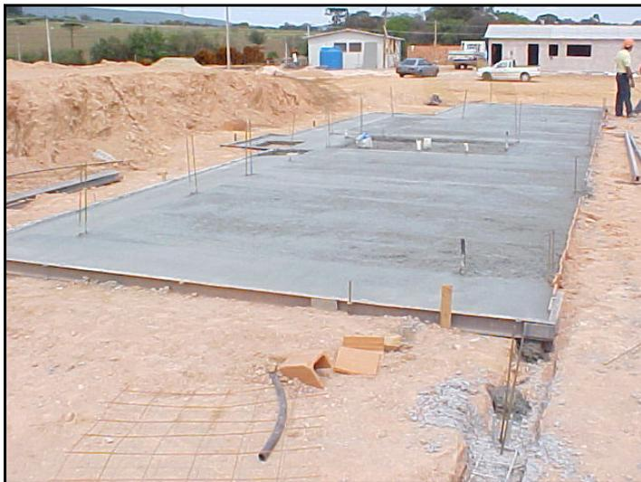
Figura 3.18 – Laje da fundação (*radier*) concretada, com os gabaritos ainda posicionados.
