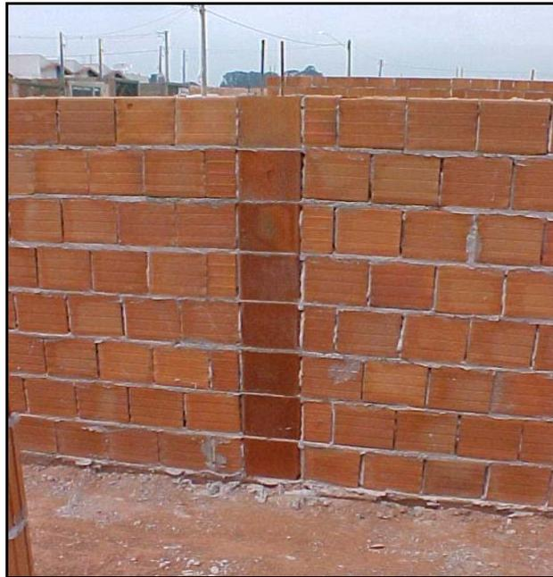
Figura 3.24 – Detalhe de um pilarete de junção de paredes.
