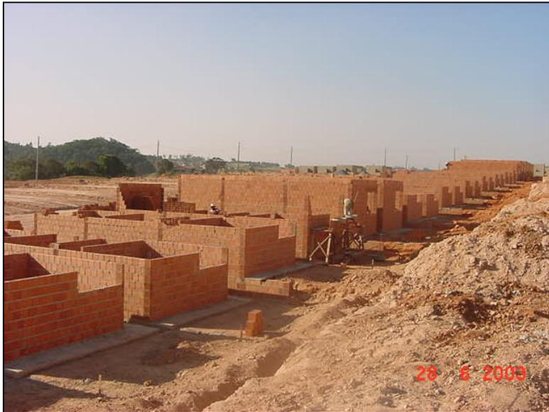
Figura 3.20 – Elevação das alvenarias em blocos cerâmicos de vedação.
