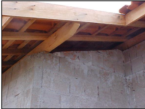
Figura 3.30 – Detalhe da estrutura da cobertura sobre a alvenaria da habitação.
