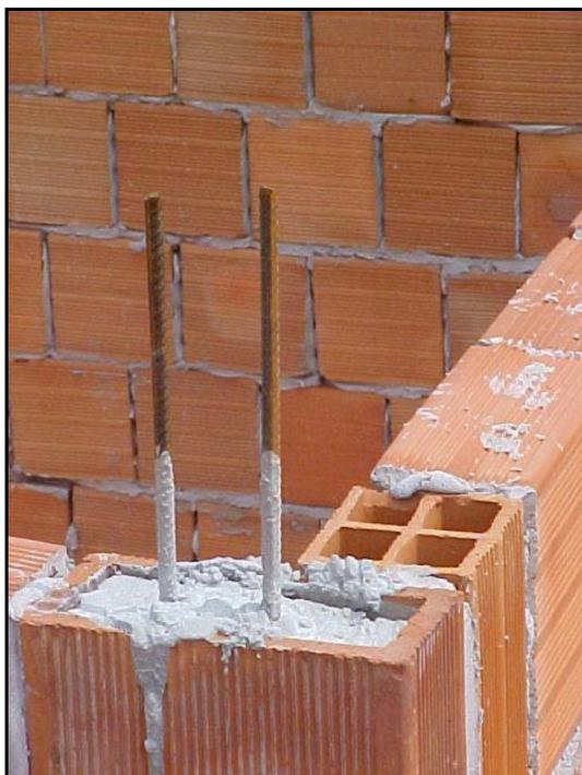
Figura 3.23 – Detalhe de um pilarete de canto na alvenaria, com duas barras de aço e *graute*.
