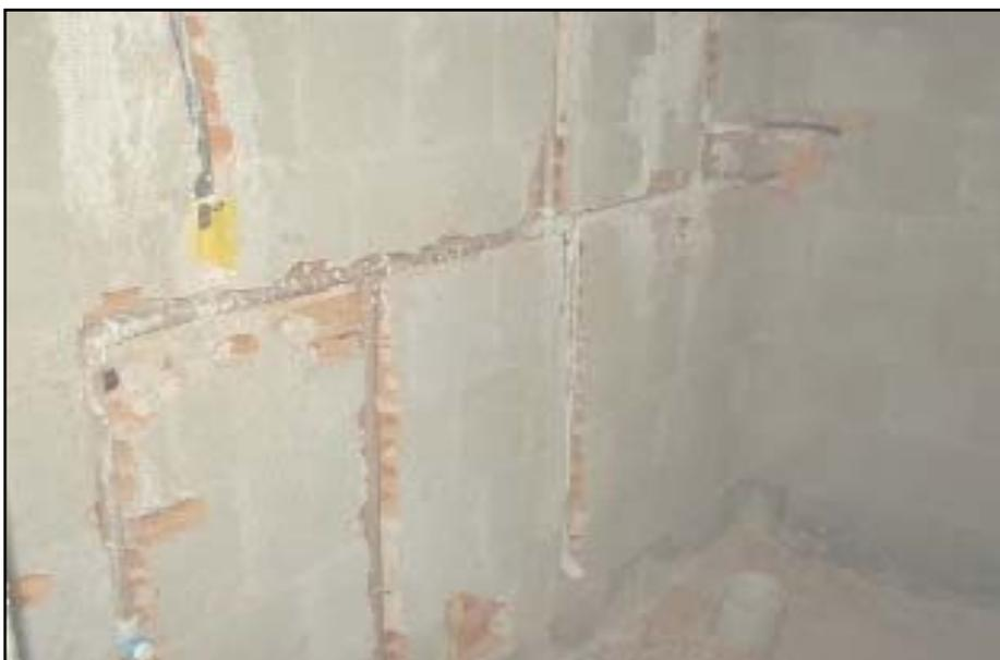
Figura 3.32 – Instalações hidráulicas e elétricas executadas na alvenaria.
