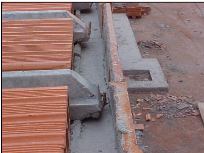
Figura 3.28 – Detalhe do posicionamento das vigotas de concreto da laje de forro sobre a última fiada da alvenaria, constituída de blocos Tipo J.
