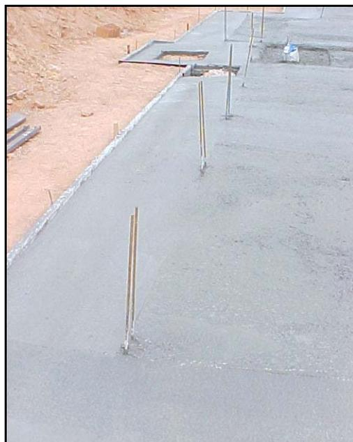
Figura 3.19 – Arranques metálicos para engastamento nos pilaretes da alvenaria.
