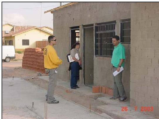
Figura 3.21 – Alvenarias com o chapisco aplicado e as esquadrias metálicas externas instaladas.
