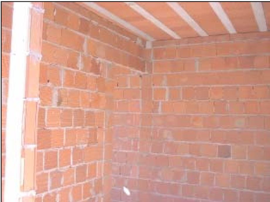
Figura 3.31 – Alvenaria na face interna da habitação, com a laje executada.
