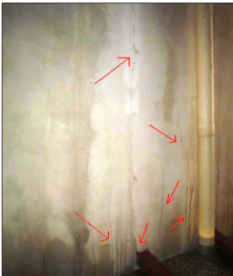
Figura 3.36 - Fissuras por movimentação higroscópica.
