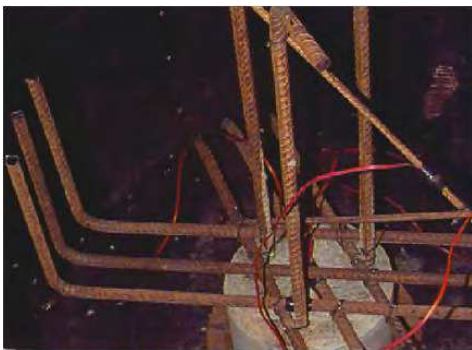
Figura 35— Extensômetro fixado a barra de aço transversal (Miguel, 2000)
