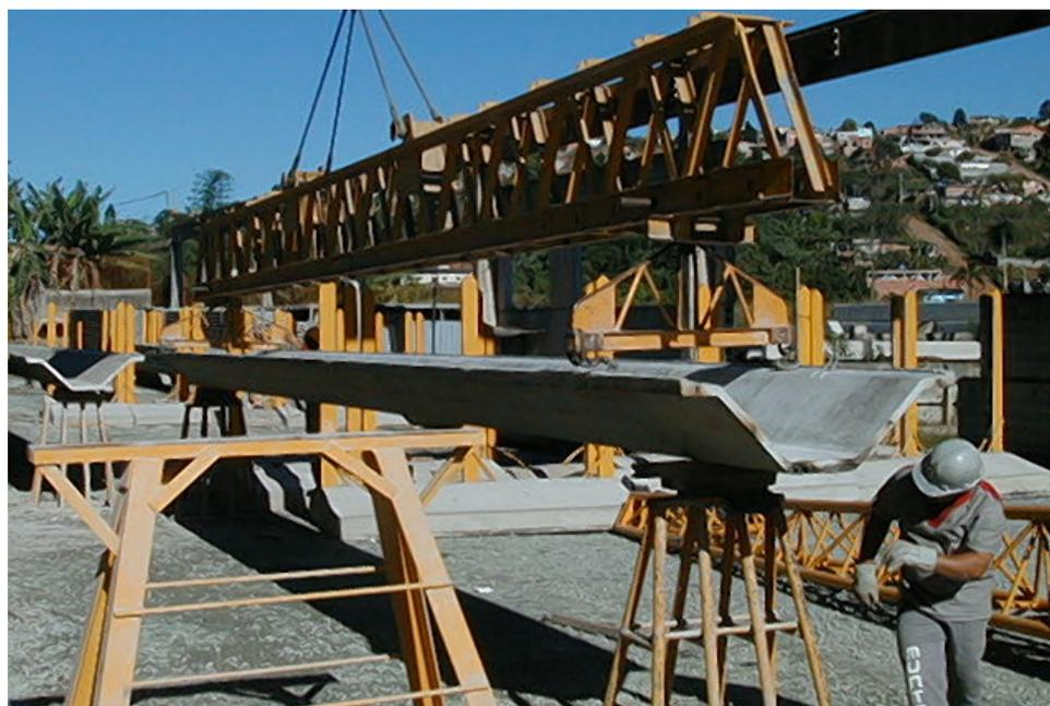
**Foto 7.** Colocação da telha na área de acabamento
