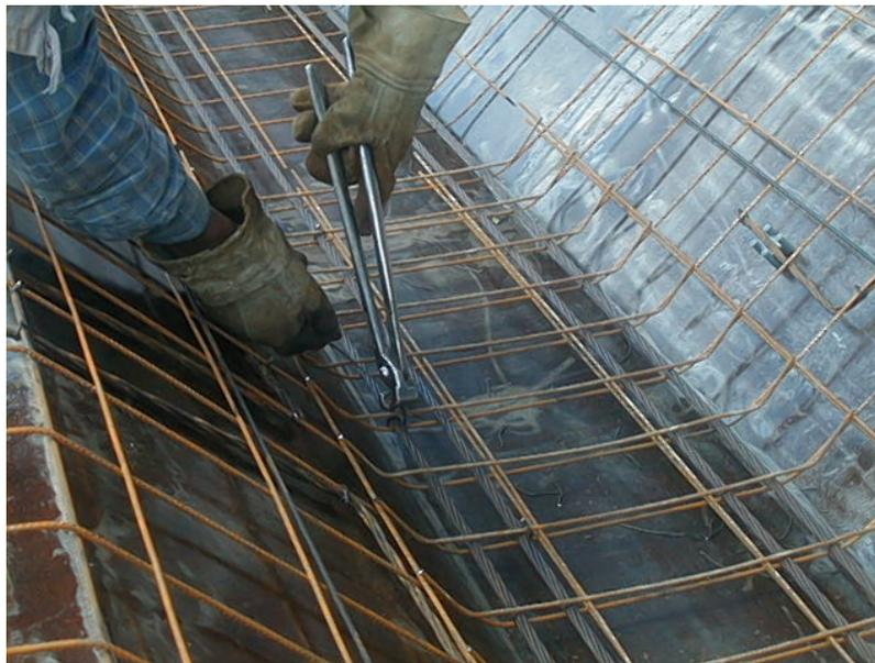
**Foto 2.** *Amarração dos cabos de protendido e a tela de aço*
