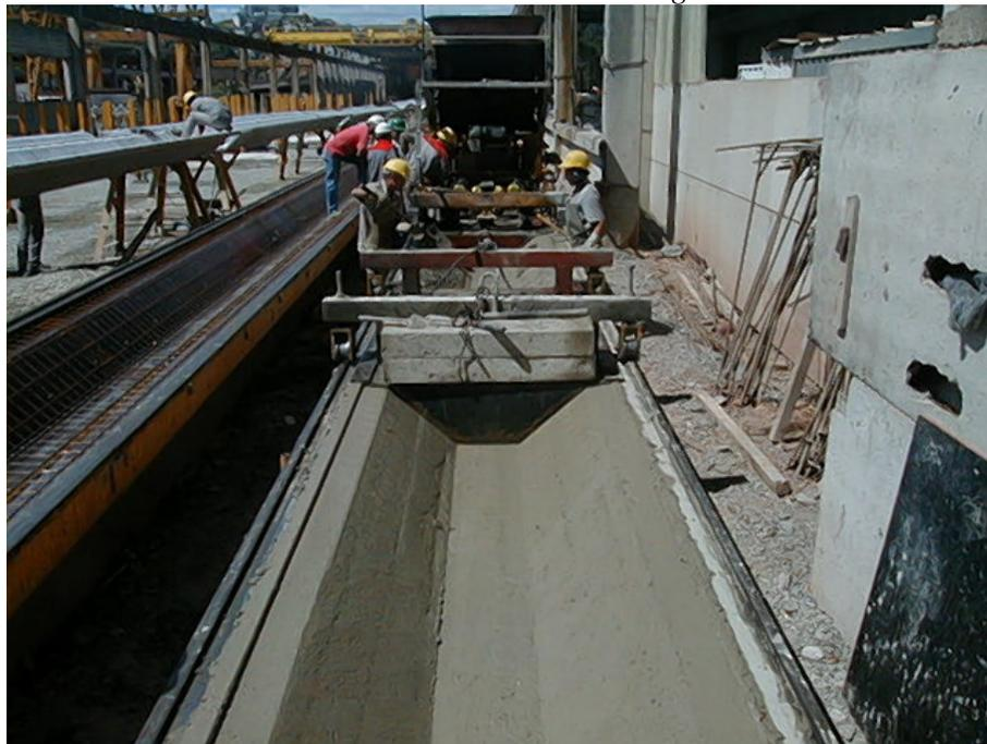
**Foto 4.** *Carrinho de concretagem e equipe de concretagem*
