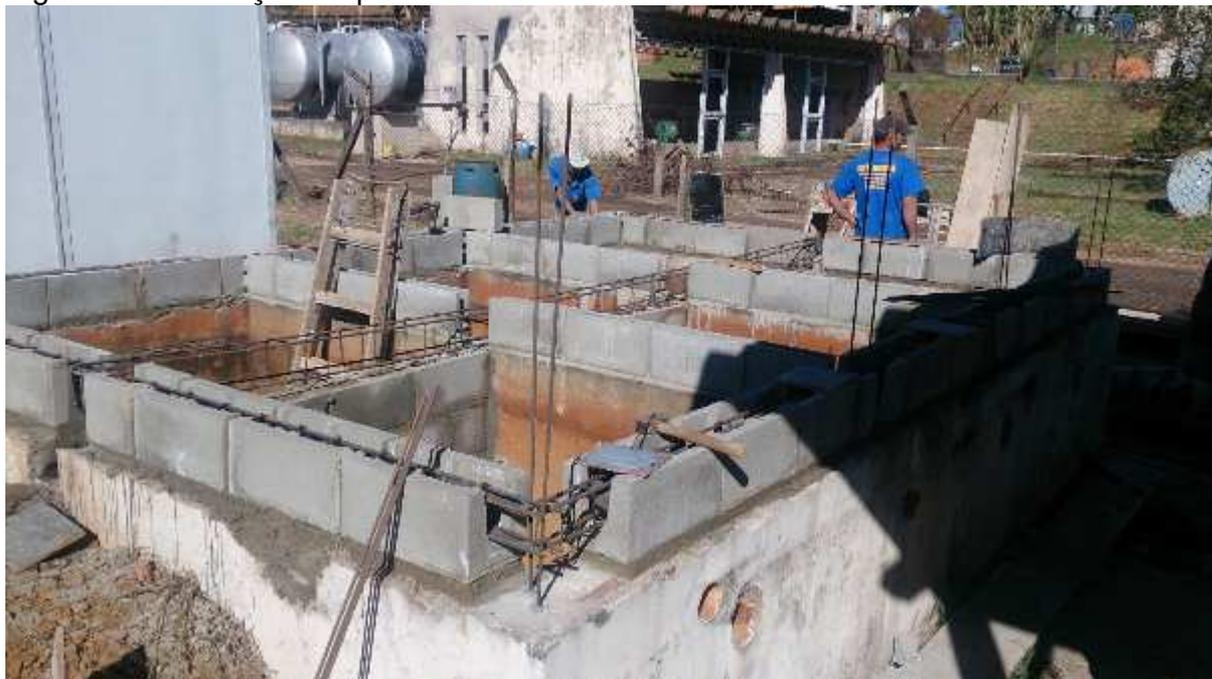
Figura 4-8 Construção dos lisímetros
