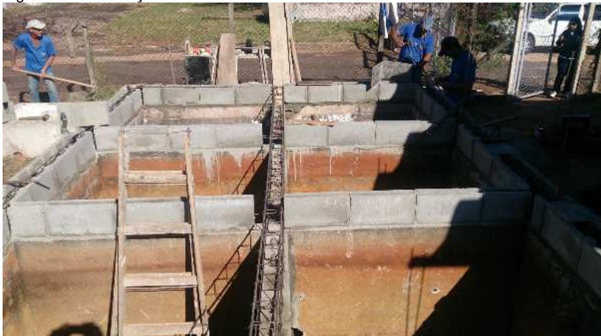
Os pisos dos lisímetros foram executados em concreto simples, com duas declividades: longitudinal ( $DL \approx 2\%$ ) e transversais ( $DTi$  e  $DTii \approx 3\%$ ), para que o lixiviado drenado fosse direcionado para um único ponto, por lisímetro. O detalhe do piso pode ser verificado na Figura 4-9 e as medidas exatas para cada lisímetro, como construídos, estão na Tabela 4-2.
