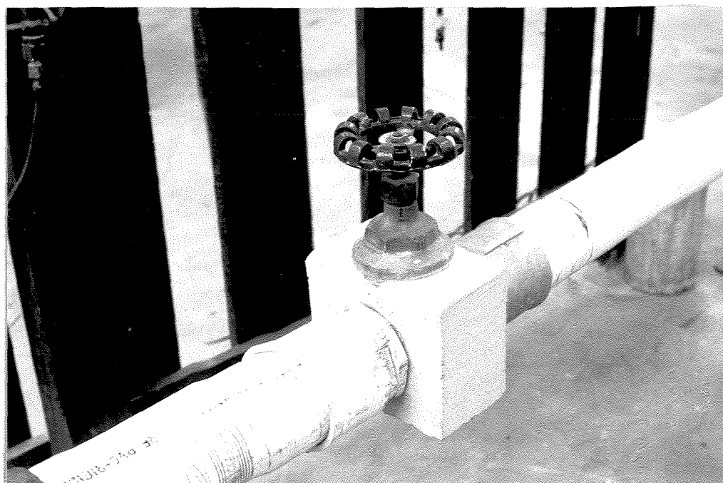
Foto 4.03. Registro com rosca revestido em concreto armado, utilizado na segunda fase de ensaios.
