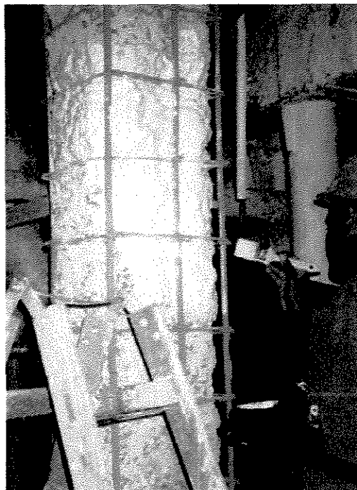
Figura 2.10 – Aplicação da resina epóxi em pilar a ser recuperado (foto da autora).
