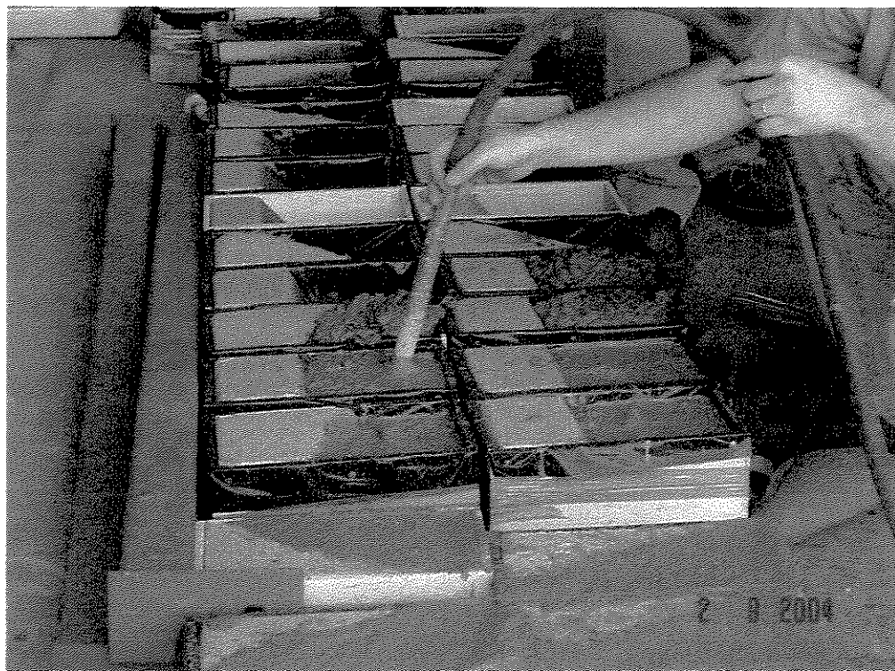
Figura 4.6 – Adensamento do concreto de reparo com uso de vibrador de imersão.
