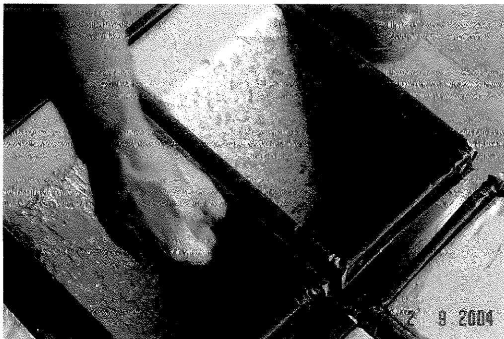
Figura 4.5 – Aplicação de adesivo à base de epóxi na junta de aderência.
