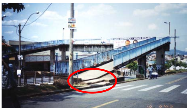
Figura 3.8: passarela com degraus para acesso a rampa
