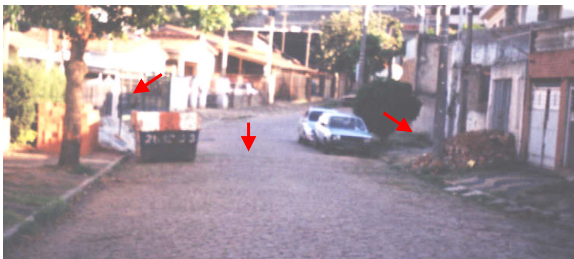
Figura 3.6 : Ao lado esquerdo materiais de obra e caçamba junto à guia, ao centro demonstra-se o pavimento em paralelepípedo e a direita entulhos acumulados em toda a calçada.
