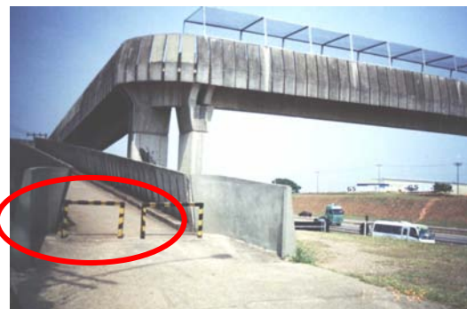
Figura 3.9: passarela com tipo de bloqueio para motocicletas
