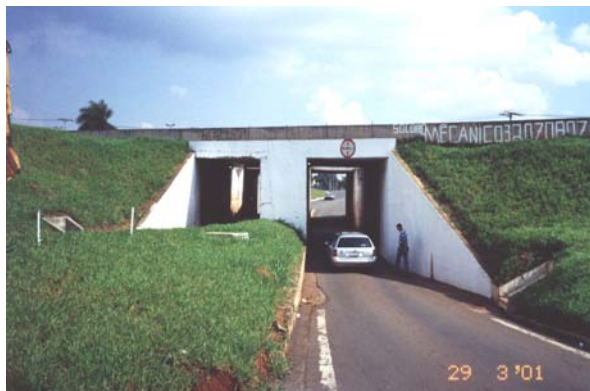
Figura 3.7: Ponte sob rodovia sem a existência de calçada para travessia de pedestres
